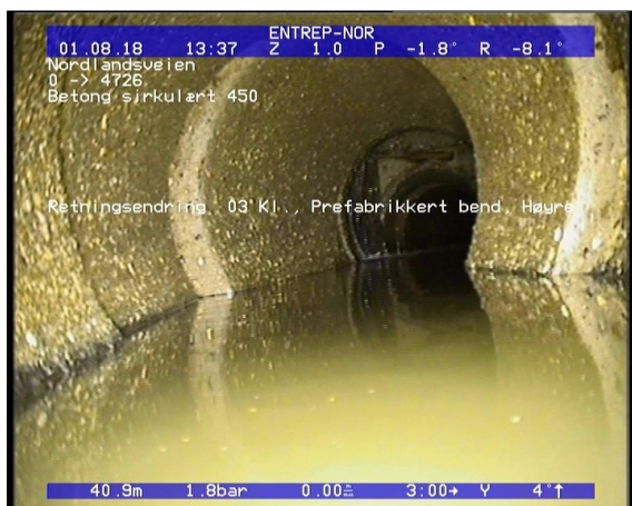
Foto: Retningsendring 03 Kl., Prefabrikkert bend, Høyre_13393940,94_RE.JPG 40,94m, Retningsendring 03 Kl., Prefabrikkert bend, Høyre
