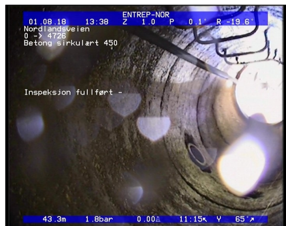
Foto: Inspeksjon fullført -_13403943,3_IF.JPG 43,3m, Inspeksjon fullført -
