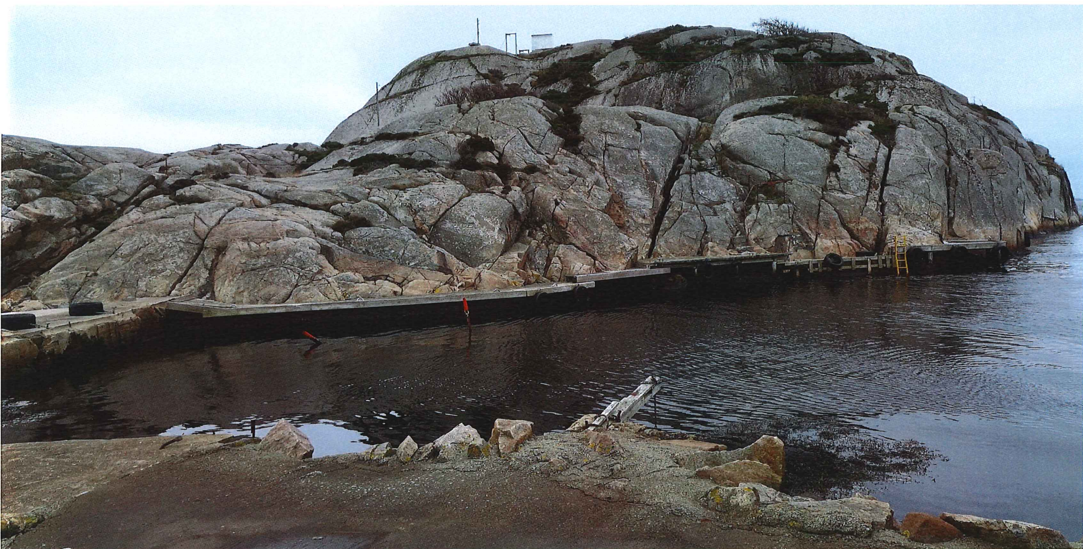
Eksisterende trebrygga som ble ødelagt under stormen Frank skal gjenbygges iført betong. 2 Fjellknauser som er markert med staker skal sprenges vekk. Sprengte steinmassen skal fraktes til land.
