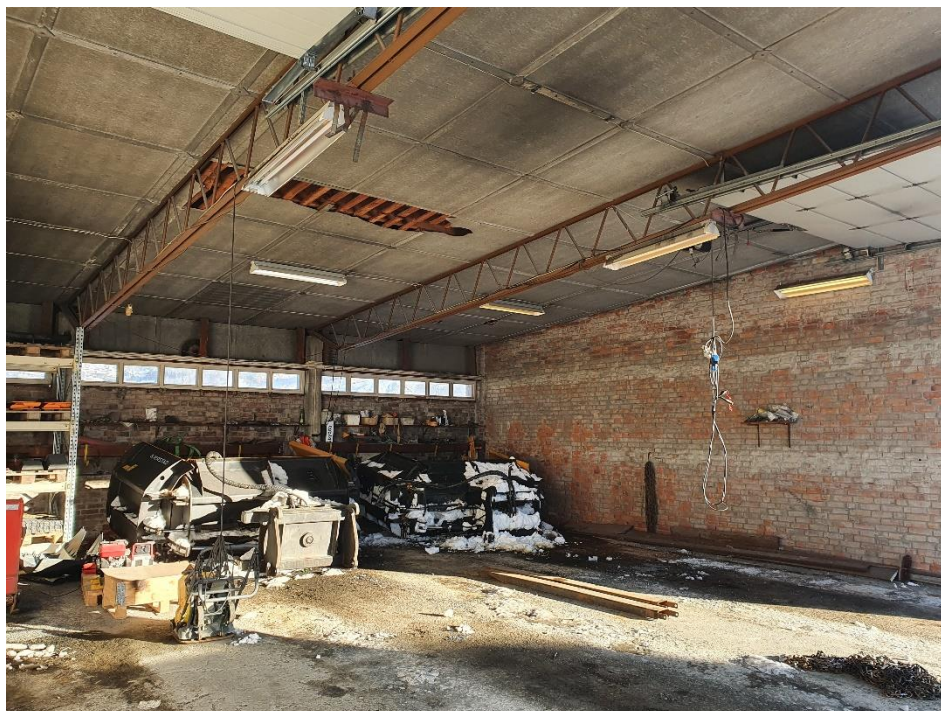
Figur 6 Gitterdragere i tak bæres av plasstøpte betongsøyler
