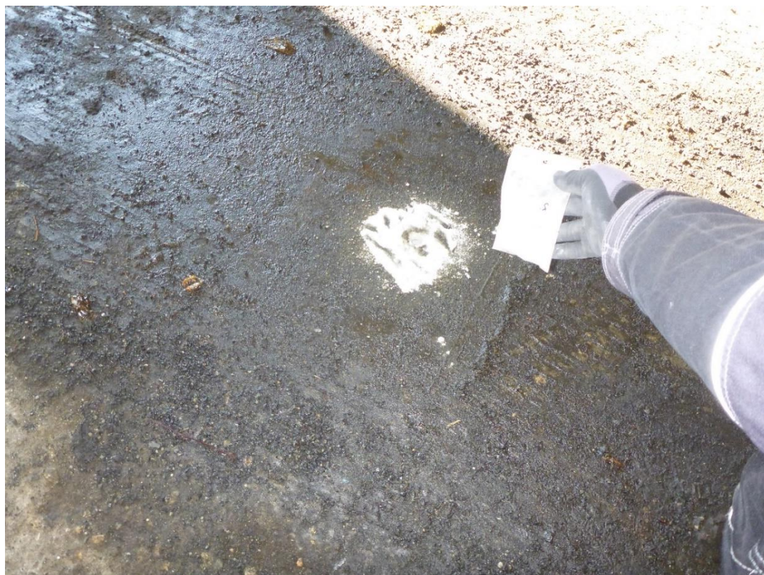
Betonggulv med olje i garasje
