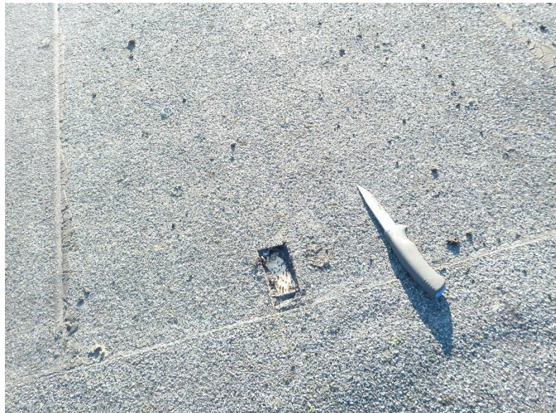
Asfaltpapp på hovedtak
