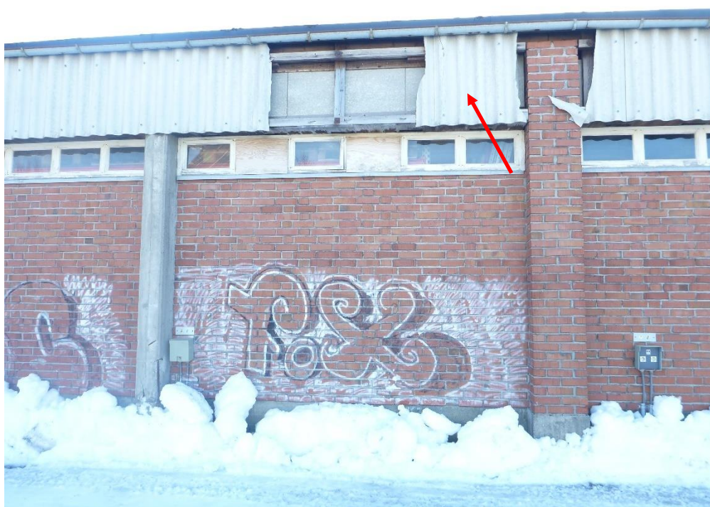
Utvendig veggplater i bølgeeternitt
