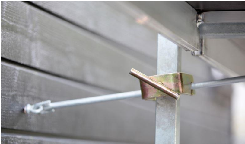
Eksempel på veggfeste. Veggfester skal være festet i spir eller ramme så nært knutepunkt med lengdebjelker som mulig.
