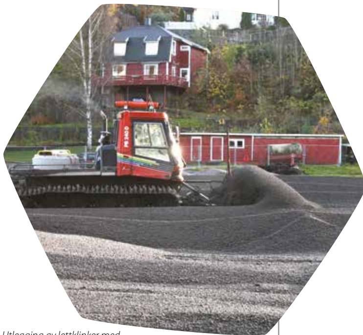
Utlegging av lettklinker med prepareringsmaskin
