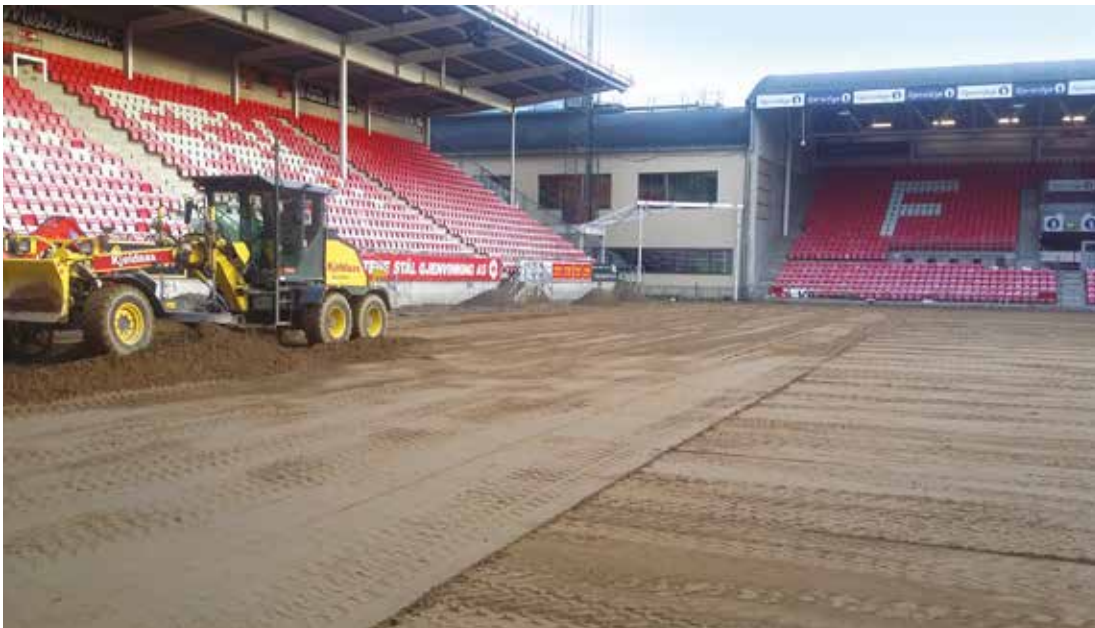
Avretting av topplag på Fredrikstad stadion
