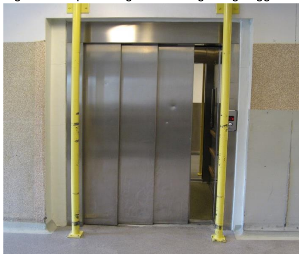
Figur 10 Stolpeløsning forankret i gulv og vegg
