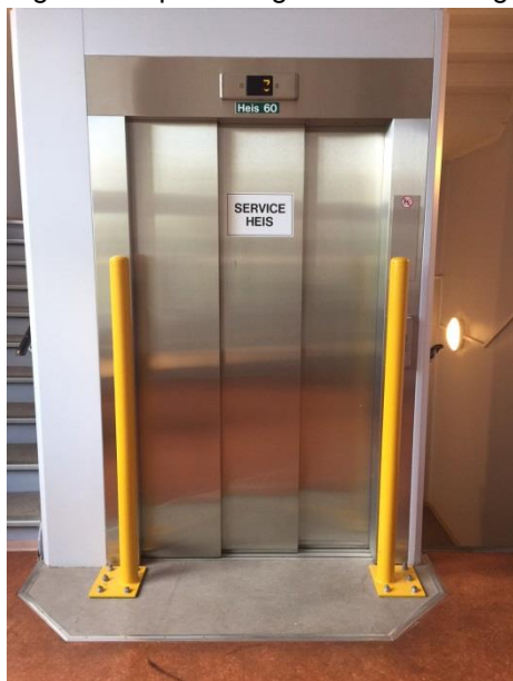
Figur 9 Stolpeløsning kun forankret i gulv
