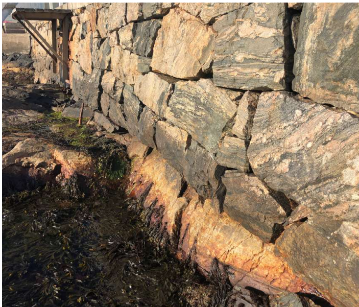
Mur Herrebadet viser «uttrykket» i dagens mur som ønskes videreført i rehabilitering av natursteinsmur.
