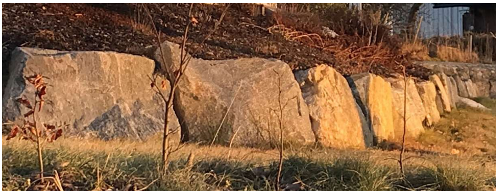
Fotoeksempel av steinkjede viser ideell utforming av steinkjeden mellom rampe og dusj.
