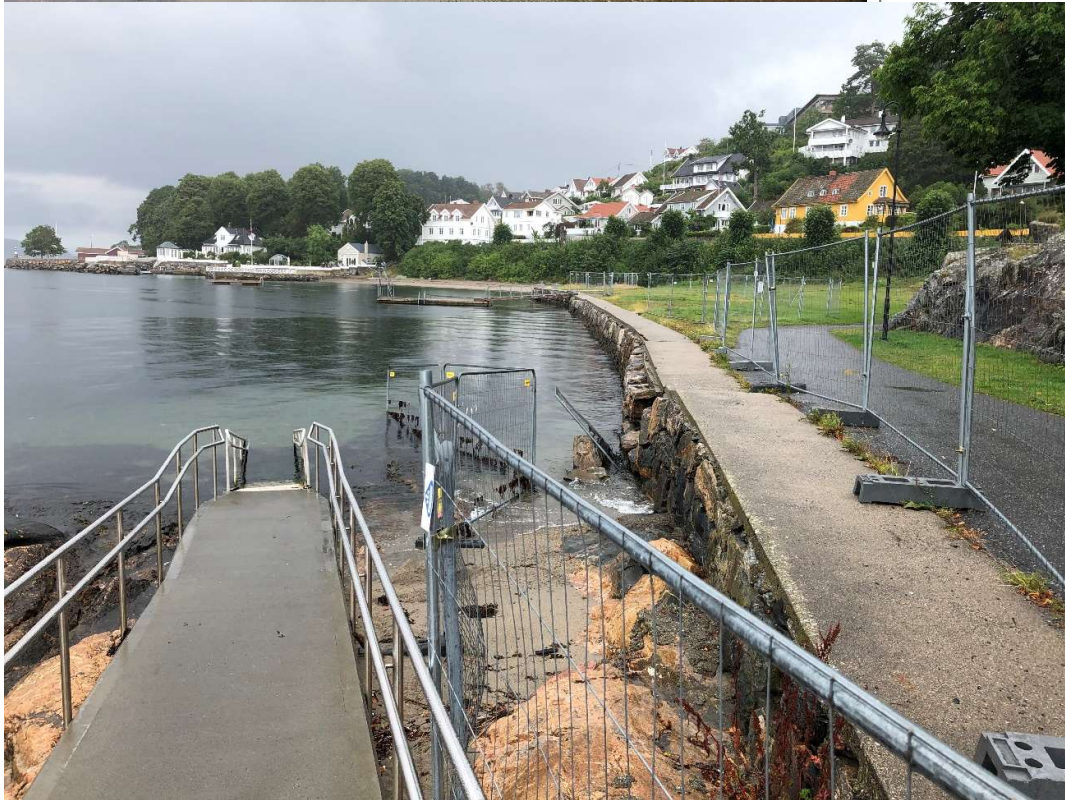
Mur 3, Handikaprampe og eksempel på skadested der stein har falt ut av eksisterende mur (ved ca. profil 20).
