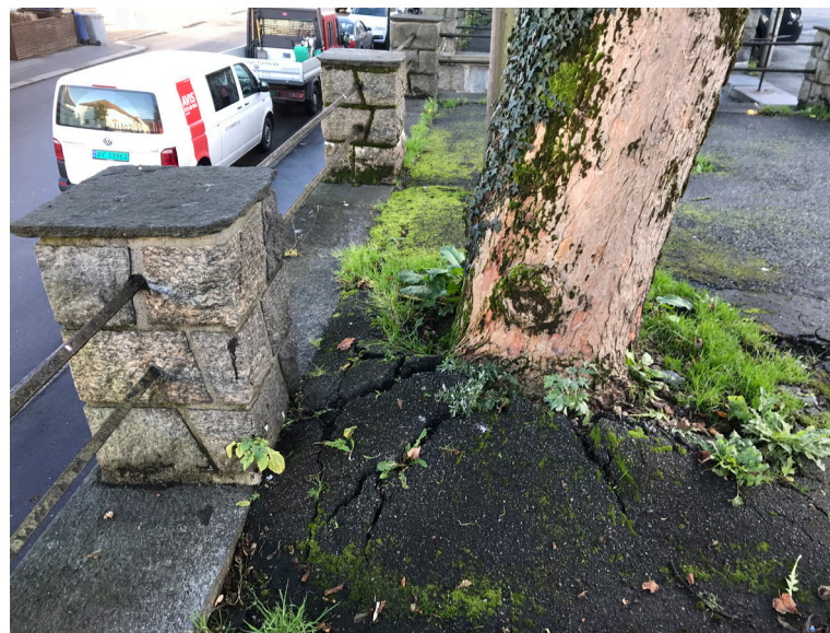
TRE SPRENGER MUREN
