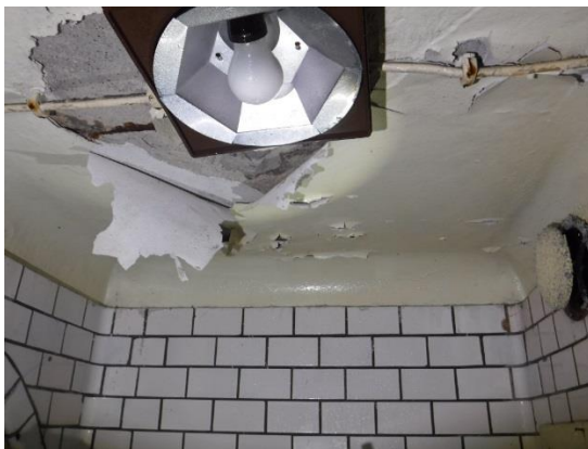
Bilde 6: Tak toalettrom
