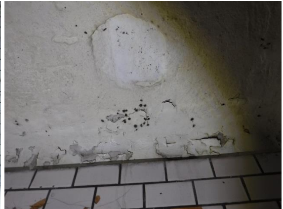
Bilde 5: Vegg toalettrom
