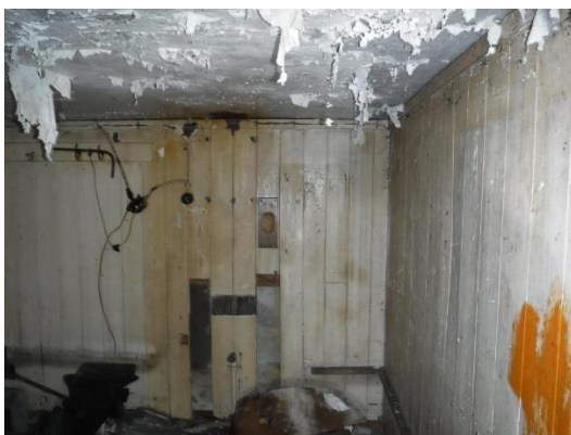
Bilde 8: Tak bensinkiosk
