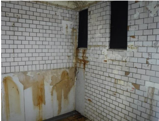
Bilde 4: Vegger og vindu toalettrom
