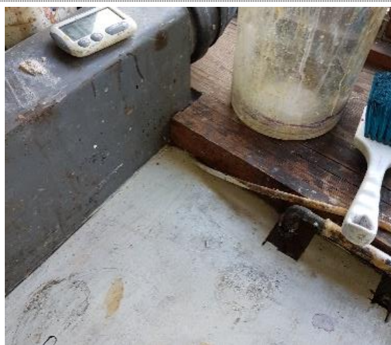
Bilde nr. E1 Kabel i klem bak bord.
