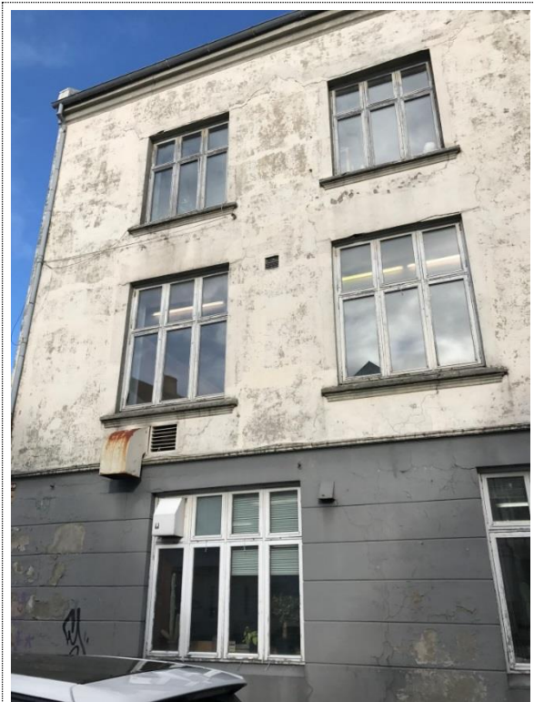
Bilde nr. 2 Fasade sør
