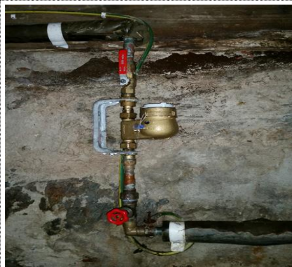
Bilde nr. V2 Vannmåler på vanninntak
