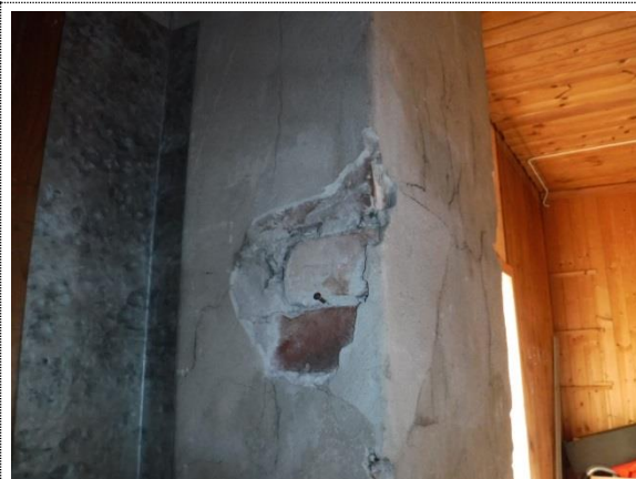
Bilde nr. 28 Løs puss på pipeløp 3.etg.
