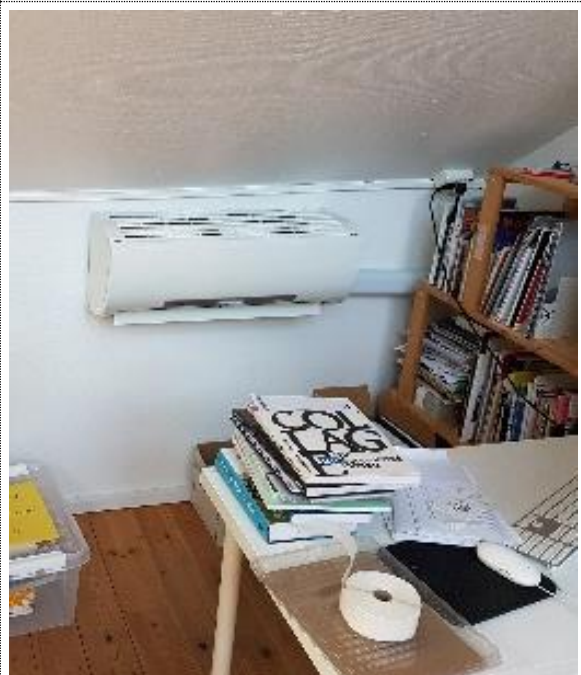
Bilde nr. E 16 Varmepumpe.
