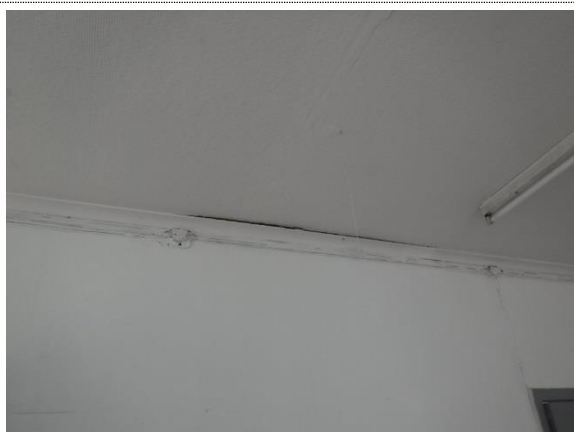
Bilde nr. 27 Glipe mellom list og tak 3.etg
