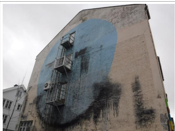
Bilde nr. 5 Fasade øst
