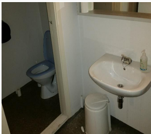
Bilde nr. V3 Sanitærutstyr med eldre togreps blandebatteri
