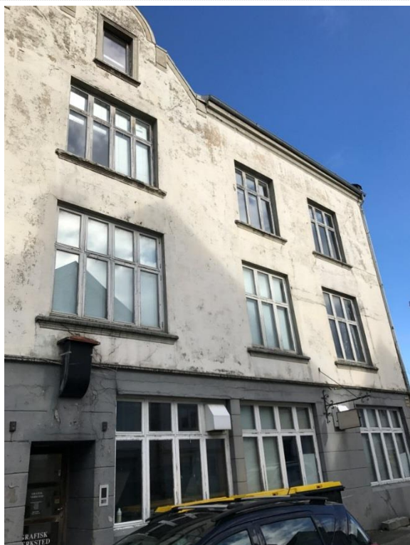
Bilde nr. 3 Fasade sør
