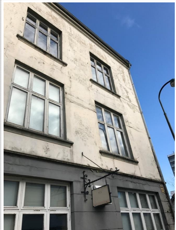
Bilde nr. 4 Fasade sør
