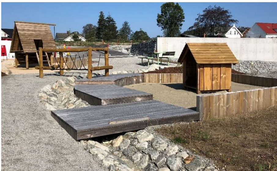
Figur 16: Steinsatt vannrenne i kombinasjon med lekeplass. Spennende landskapselement som inviterer til lek ved både opphold og nedbørsperioder. Foto fra befaring i etableringsfasen.
