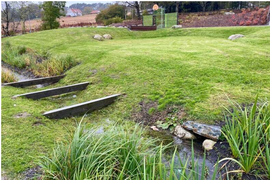
Figur 15: Swale med terskler og overganger.
