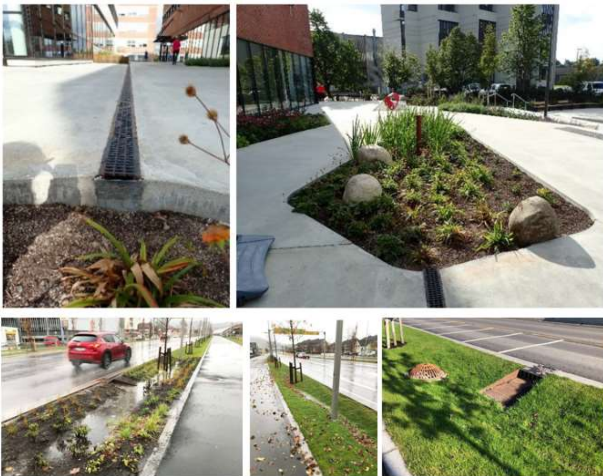
Figur 10 Eksempler på overvannsløsninger i trinn 1. Topp: renne som samler avrenning fra harde flater til bed ved Ulvenveien torgplass i Oslo. Bunn: Kjeftsluk med renne som fører overvann fra kjørebane til forsenket grøntribatt med regnbed ved Bjørnstjerne Bjørnsons gate i Drammen (hentet fra www.vanytt.no ).
