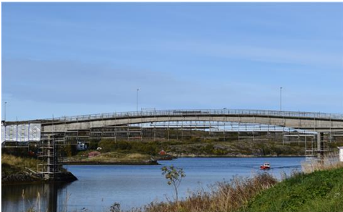
Gamle Herøysundet bru under vedlikehold sommeren 2020
