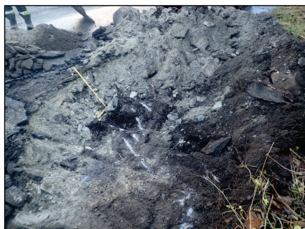
Figur 12: Prøvegrop HH-4, tynt bærelag med lys, finknust stein under asfalt. Torv fra ca. 0,5 meter, fast fjell på ca. 0,6 m.
