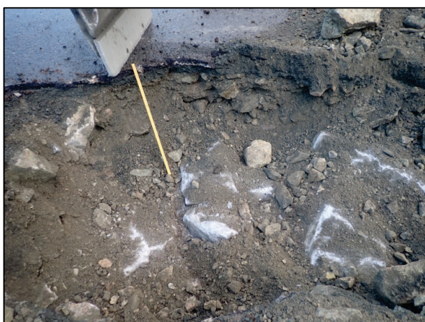
Figur 11: Prøvegrop HH-3, tynt bærelag av finknust stein under asfalt, over spengstein med grus.
