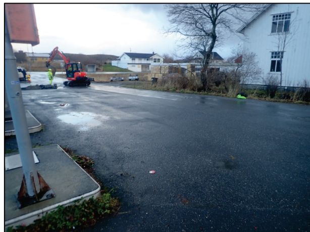
Figur 8: Bilde fra pumpene. Graving av HH-2. Gul markør ved prøvepunkt HH-4.
