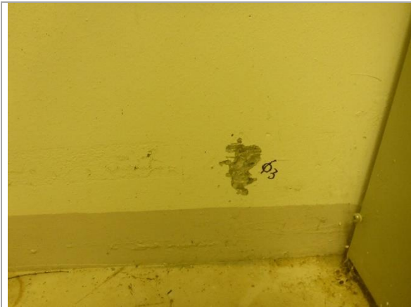
Bilde 7: Betongvegg i kjeller.
