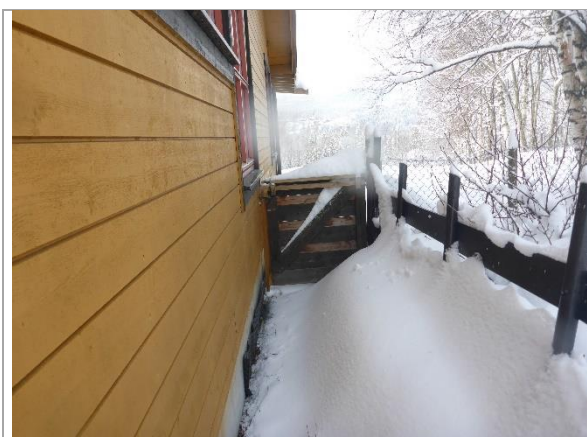
Bilde 17: Impregnert trevirke benyttet på port og gjerde.
