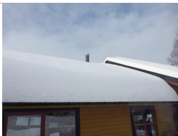
Bilde 28: Utvendig stålpipa
