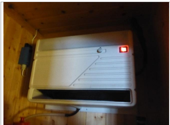
Bilde 29: Kjøleaggregat i kjølerom kjøkken.
