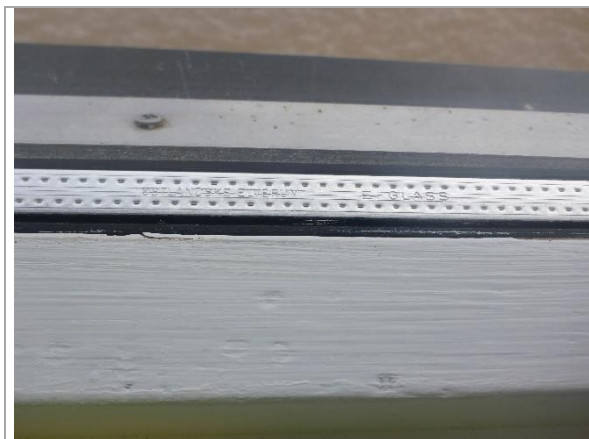
Bilde 21: Isolerglass i vindu fra 1989
