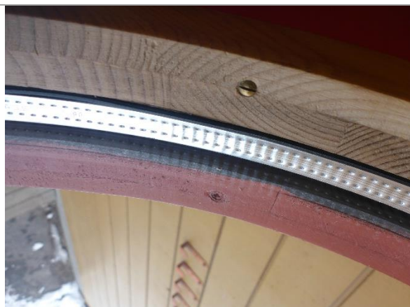
Bilde 22: Isolerglass i runde glass i dører 1989
