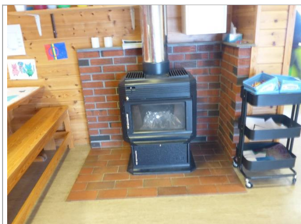
Bilde 27: Vedfyring med stålpipa
