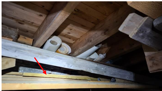
Bilde 12 – Små forekomster av trykkimpregnert trevirke i kjeller (pil). Ruller med beleggrester.
