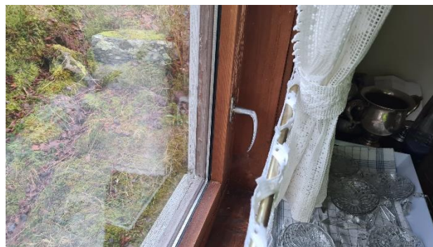
Bilde 7 – Kjøkkenvinduet har isolerglass med smal avstandslist.
