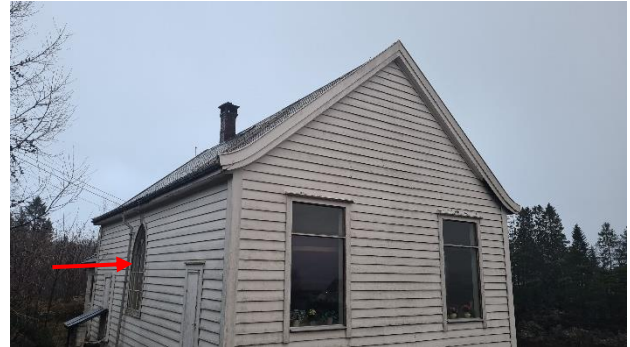
Bilde 4 – Det store vinduet på langveggen (pil) er prøvetatt for asbestholdig kitt, uten funn av asbest. Det er 3 slike vinduer på motsatt langside.
