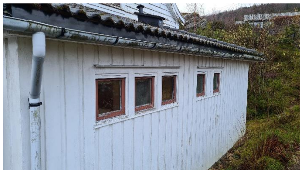
Bilde 6 – Små isolerglassvinduer i gang og WC, det midterste har glass fra 2015.
