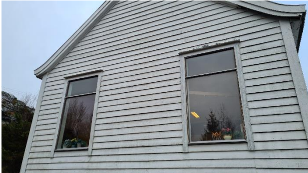
Bilde 3 – Det høyre vinduet på bildet har asbestholdig kitt mellom glass og karm innendig. Tilsvarende antas å gjelde for begge de øvre glassfeltene.
