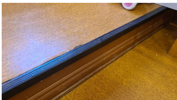
Bilde 8 – Den mest forekommende typen vinylbelegg, samt trappeneser på repos i sal.
