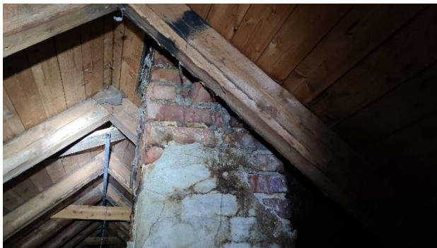
Bilde 18 – Skorstein, sett fra loft.
