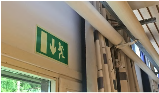
Figur 2 Fluoriserende rømningsskilt.
