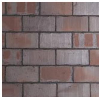
Bilde 5: Det bygges marktegl på gang- og oppholdsarealer
