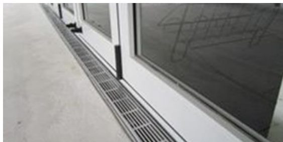
Bilde 3: Acodrain ved byggets fasade mot nord
