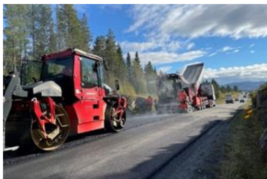
Bilde 4: Klimavennlig asfalt som legges på E14 i Meråker
