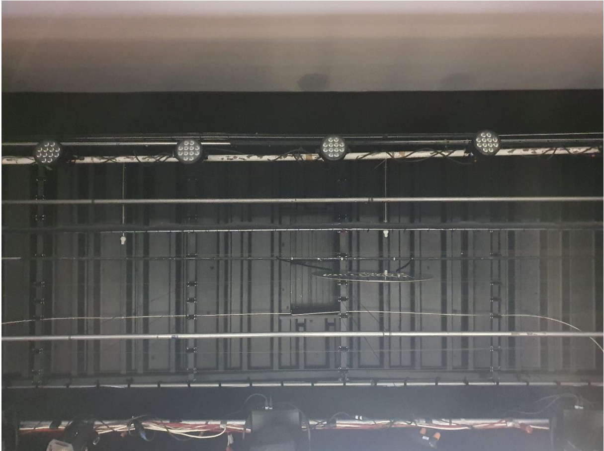
Deler av snorloft-tak over scene, med H-bjelker som bærer dagens scenetrek
