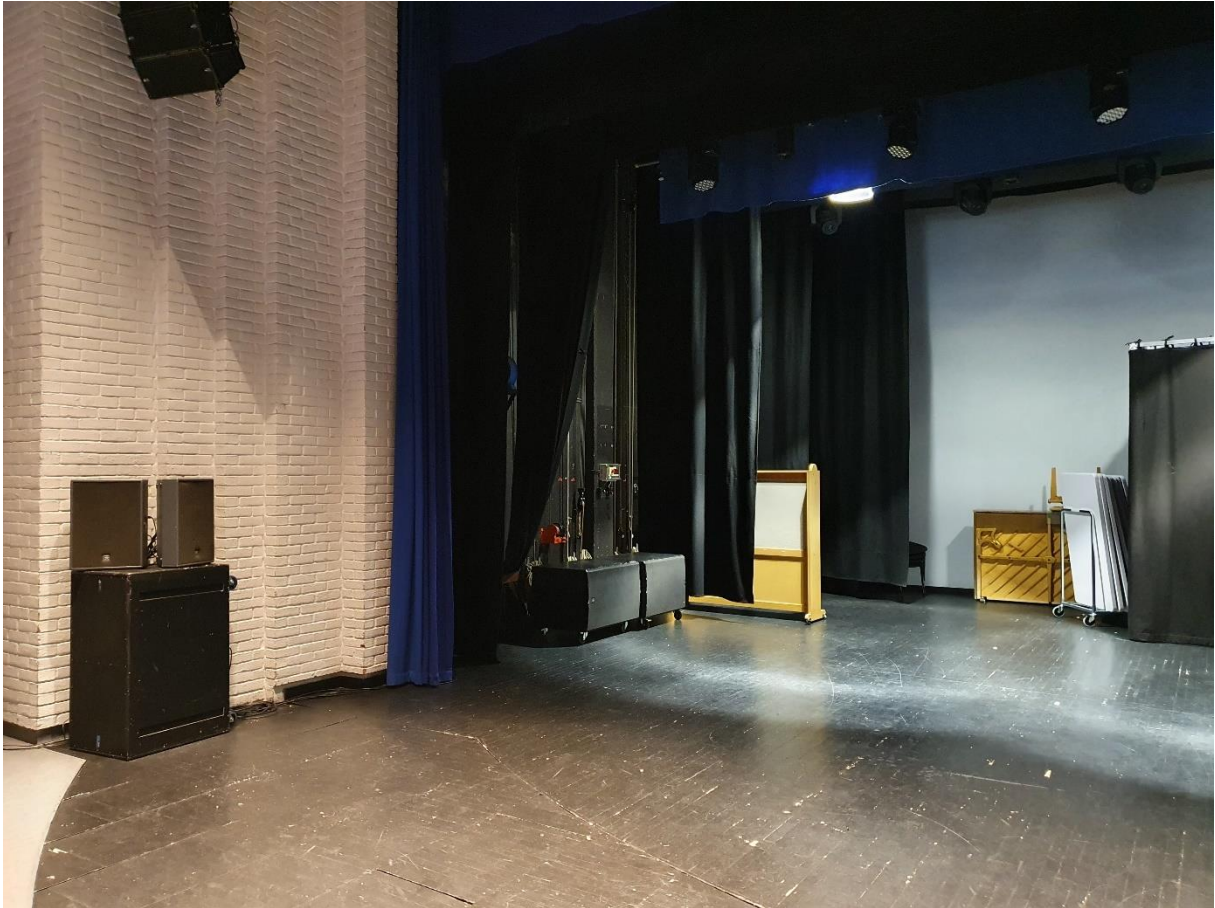
Venstre scene, oversikt. Gulvet er tre-staver, delvis ganske sprøtt/tørt, som må forsterkes med plater ved tungt liftarbeid.
