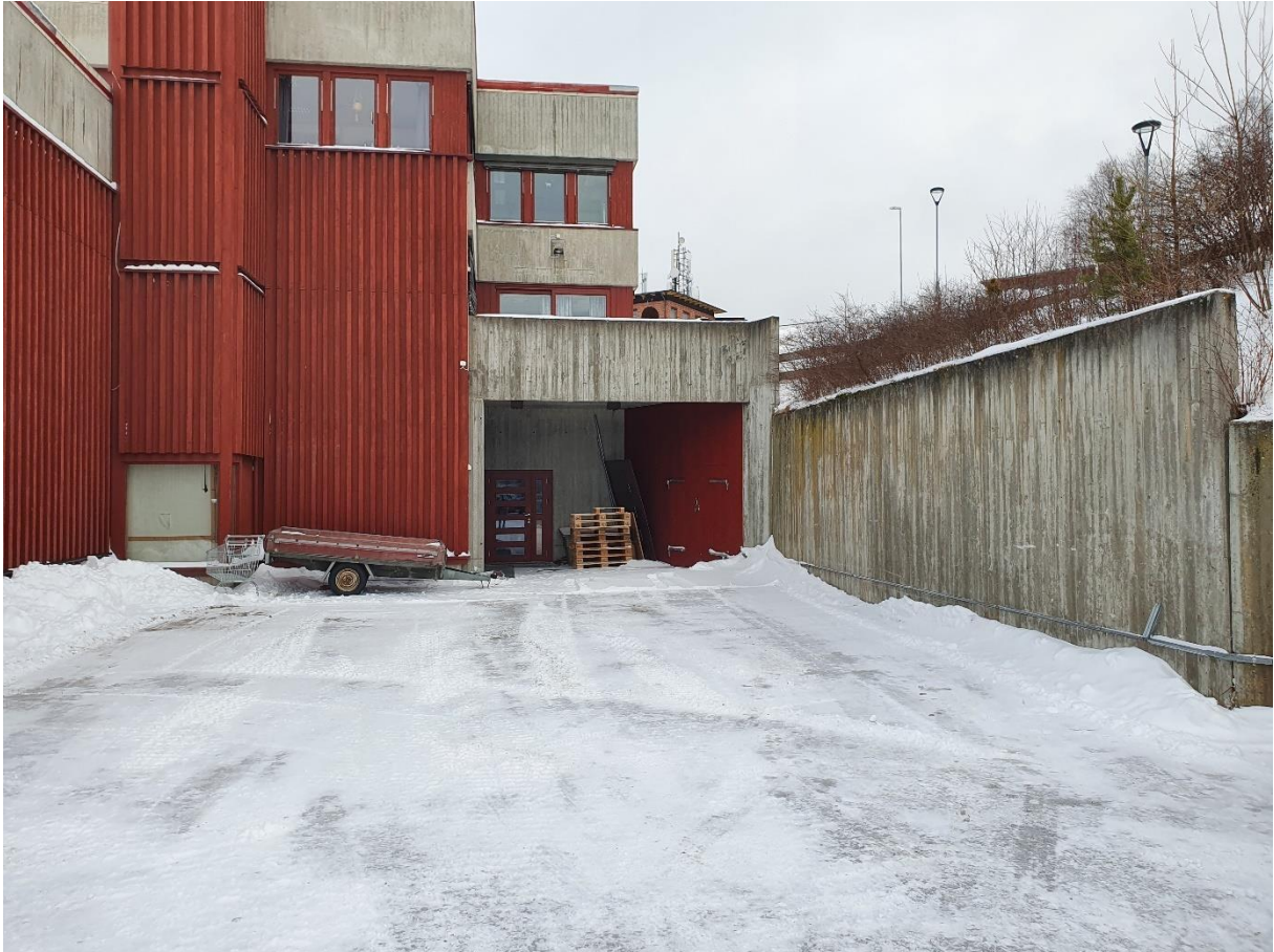
God plass på utsiden til avfallscontainere og tilgang lastebiler. Innlast scene midt på bildet
