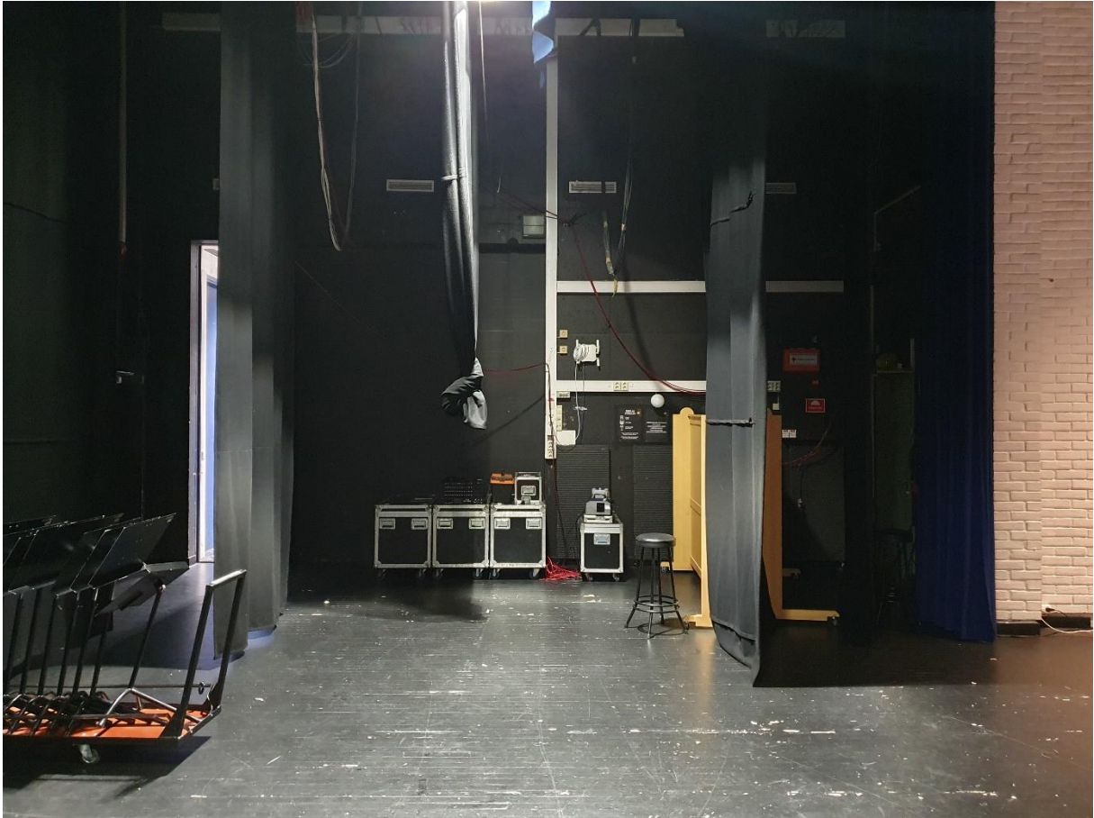
Sidescene høyre, framre del. Inngang til dimmerrom er skjult t.h. på bildet bak forreste bein/forteppet. (Bak den hvite proscenieveggen). 30 patchkontakter til lystrekk i scenerom sees så vidt øverst i bildet (hvit kanal)
