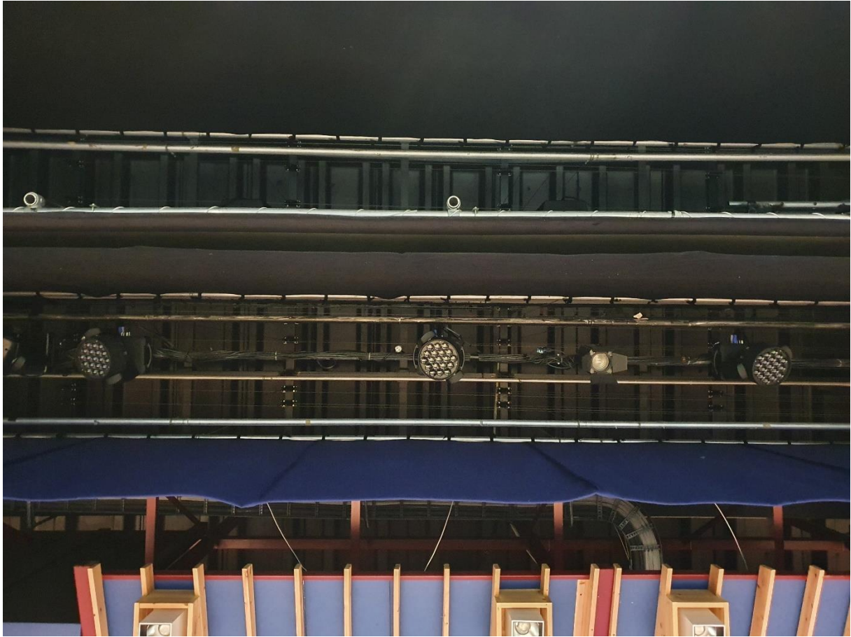
Snorloft-tak over for-scene, mot H-bjerkene som bærer dagens trekk.
