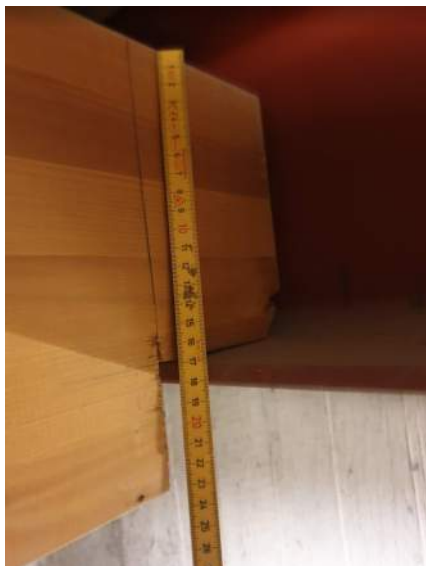
Figur 29 - Innsnitt i limtrebjelkene
