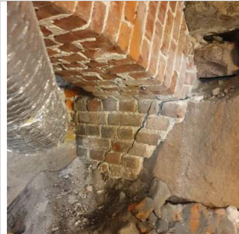
Figur 17 – Bilde 5 - Skråriss under murbue
