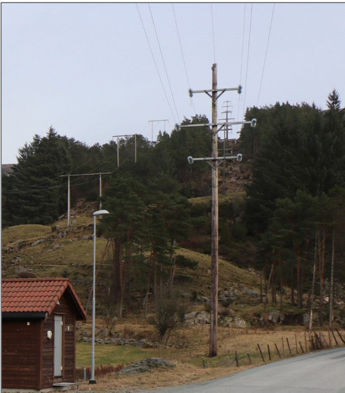
Figur 3. Mast 342 og 342A er utført i tre rundstokk. Bilde viser mast 342.
