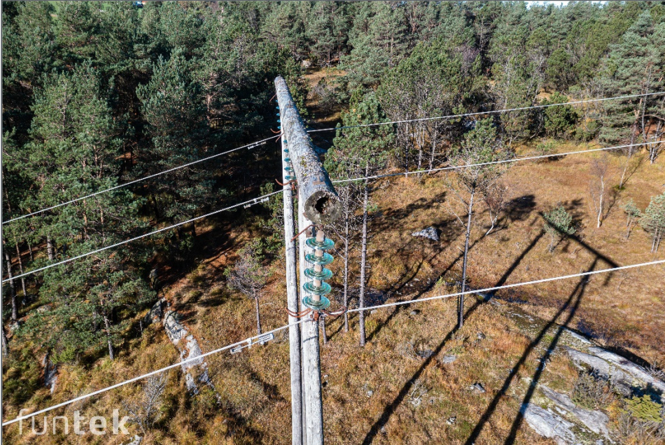
Illustrasjon: 66 kV tremast mellom Ølen og Våg.
