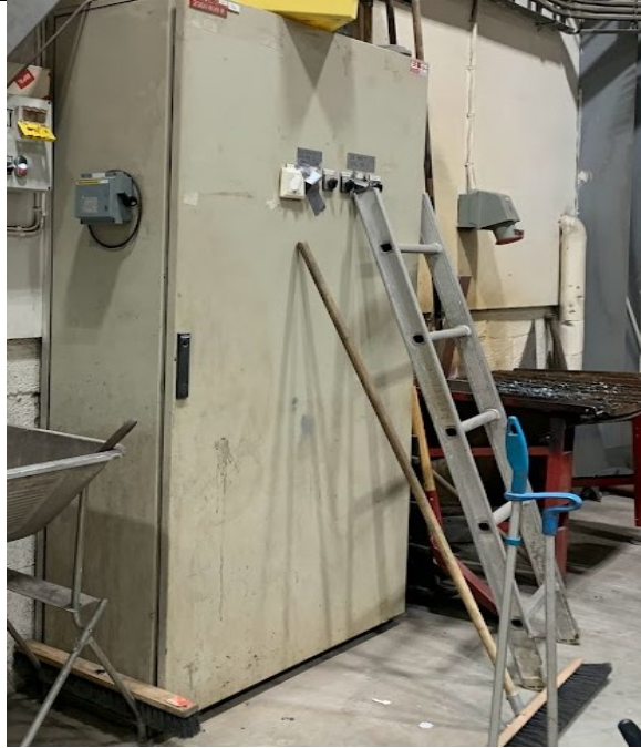
Bilde nr.: 13- Sveiseverksted
