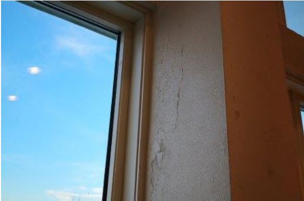
Figur 4: Sprekker/riss betongsøyle
