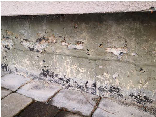
Figur 5: Avflassing/forvitring grunnmur
