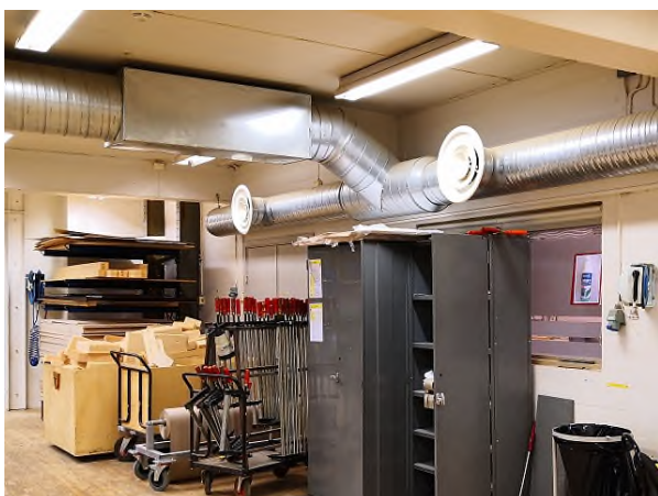
Figur 28: Balansert ventilasjon i verksted
