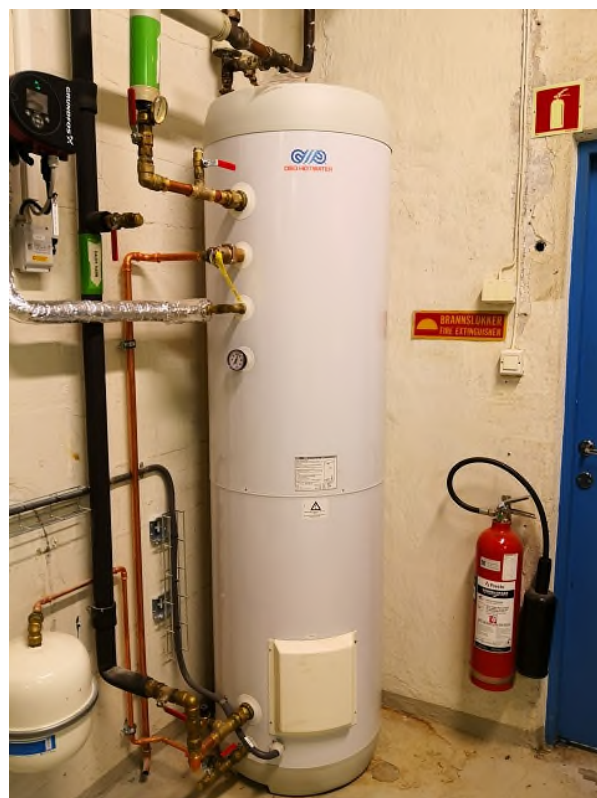
Figur 25: Ny varmtvannsbereder
