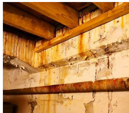
Figur 9: Betong i kjeller
