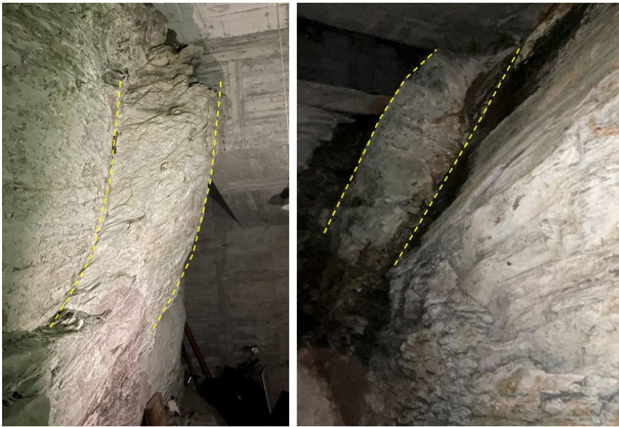
Figur 6. Foto fra kjelleren i bygget rett nordvest for planlagt byggegrop for fløy A, se Figur 5, viser en grønnstein. Bildet til venstre er tatt mot sørvest og viser sprekker med steilt fall mot sørøst. Bildet til høyre er tatt mot nordøst og viser sprekker med fall på omkring 60° mot nordvest.
