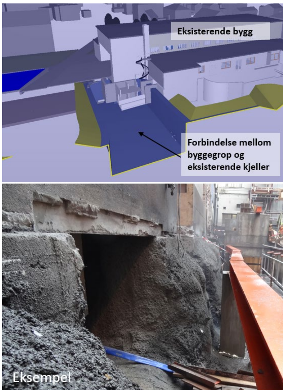
Figur 11. Øverst: Kjelleren under slepetanken skal forbindes med kjeller under fløy A. Nederst: Eksempel på uttak av berg inntil og under eksisterende bygg. Merk at eksempelet viser en passasje som er langt mindre enn den som er planlagt ved OSC.
