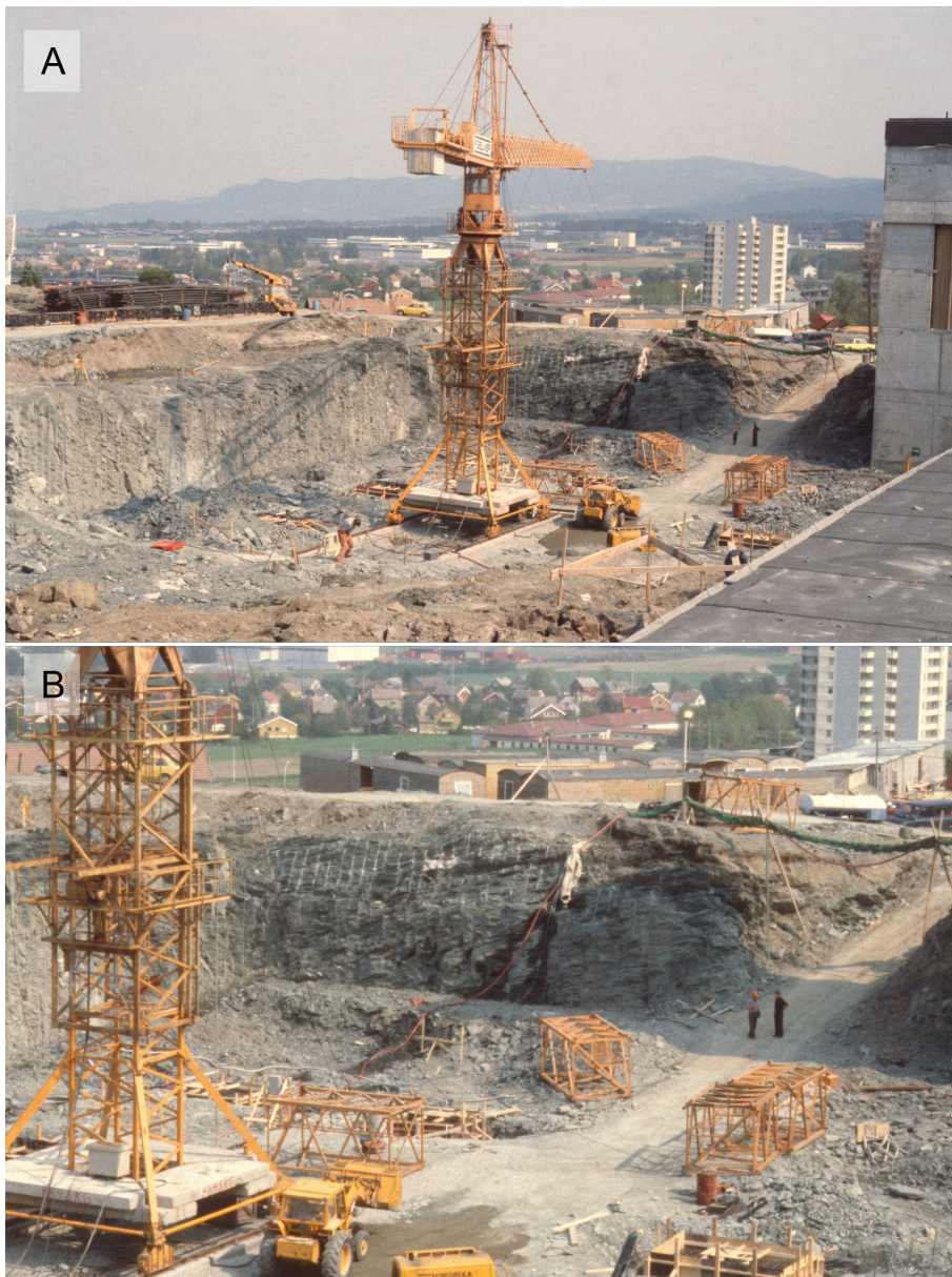
Figur 9. Bilder fra bygging av skipsmodelltank, datert 1979. A: Bergvegg i nordøst og sørøst. B: Bergvegg i sørøst. Bergveggene i nordøst og sørøst er tilsynelatende stabile uten tung bergsikring. Se Figur 5 for plassering i forhold til prosjektert byggegrop.
