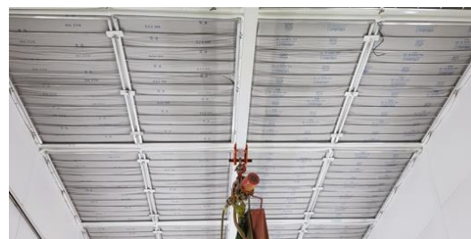
Bilde: Utsnitt av taket inne i lakkboks.
