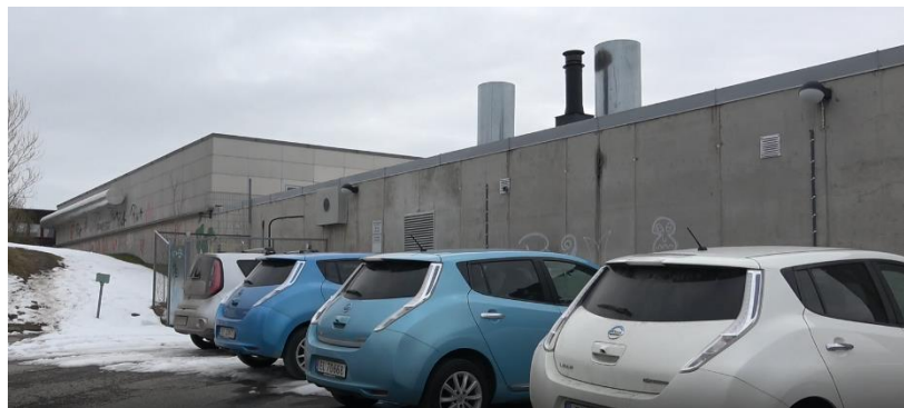
Bilde: Fassade mot nord
