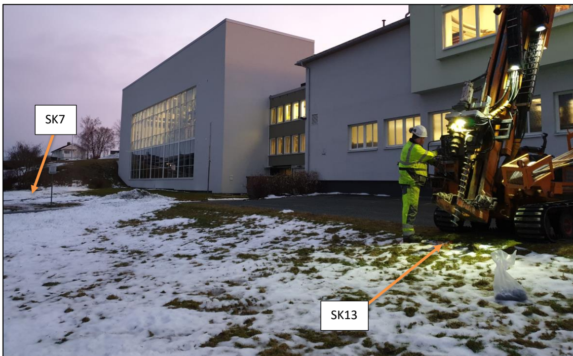
Figur 12: Nordvest på planområdet, ved Skipsmodelltanken. Plassering av prøvepunktene SK7 og SK13 er vist. Foto: Multiconsult.
