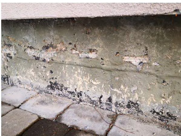
Figur 5: Avflassing/forvitring grunnmur
