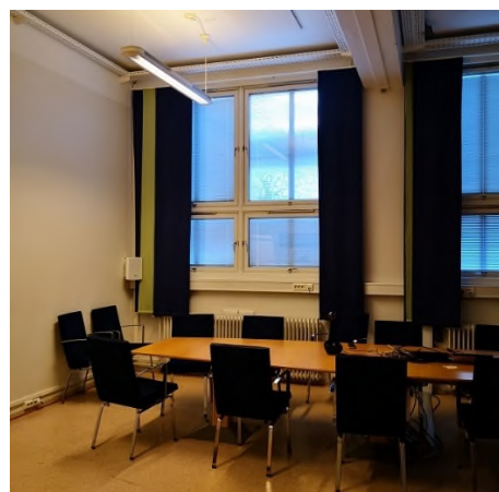
Figur 29: Ingen ventilering av møterom
