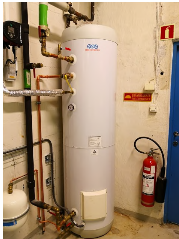
Figur 25: Ny varmtvannsbereder
