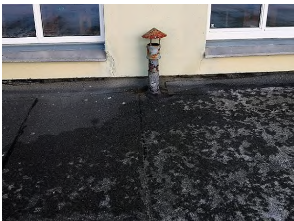
Figur 18: Gamle tak, tekking og luftehatter
