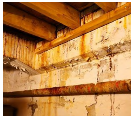
Figur 9: Betong i kjeller
