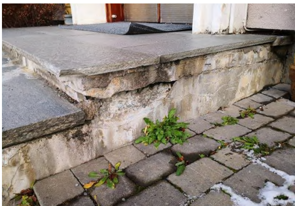
Figur 22: Utvendig skiferbelagt betongtrapp
