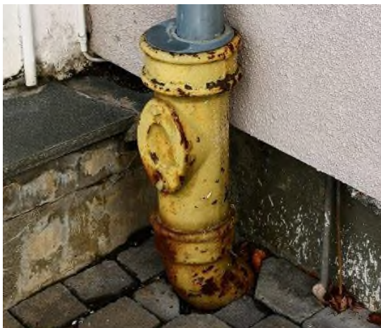
Figur 2: Gamle soilrør, gammel drenering
