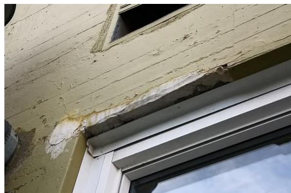
Figur 7: Mulig strukturelle skader i betong
