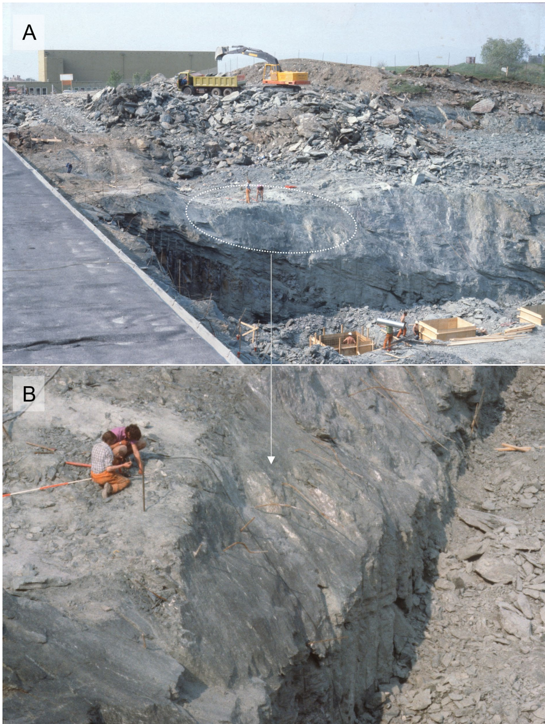
Figur 5. Bilder fra bygging av skipsmodelltank, datert 1979. Bildene viser spor etter stor utglidning langs glatt sprekk, trolig foliasjonsplan, med fall på omkring 50-60° i bergveggen i nordvest. Bilde B viser nærbilde av glideplanet markert med stiplet ellipse i bilde A. Sprekken som definerer glideplanet ligner på sprekker med klorittbelegg observert i utborede kjerner. Se Figur 4 for plassering i forhold til prosjektert byggegrøp.
