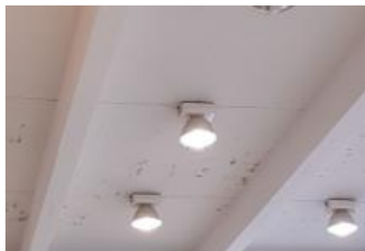
Bilde: Stedstøpte etasjeskillere med integrerte bjelker
