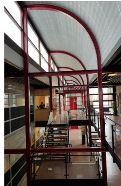
Bilde: oppbygd tak i fellesareal.
