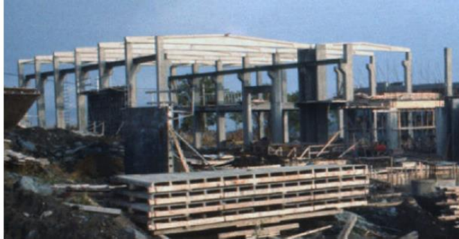
Bilde: K-lab under oppføring. Bildet viser bæresystemet med prefabrikkerte søyler og dragere.
