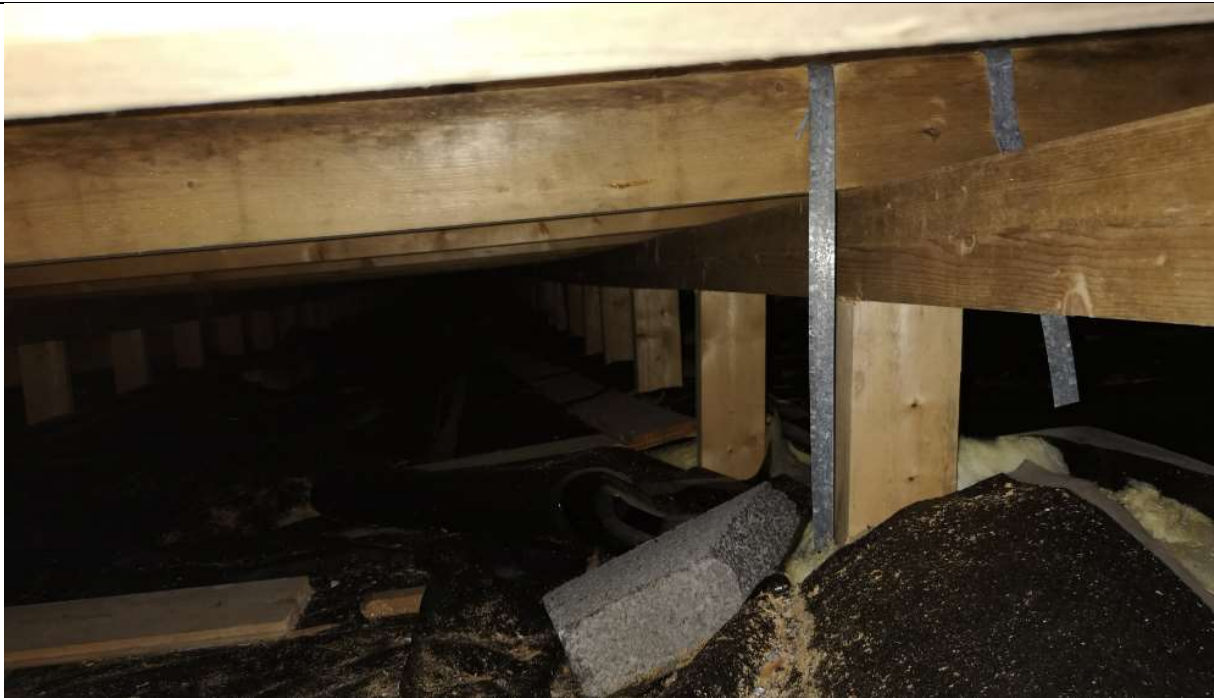
Bilde 1: Oppbygging takkonstruksjon sidetak.
