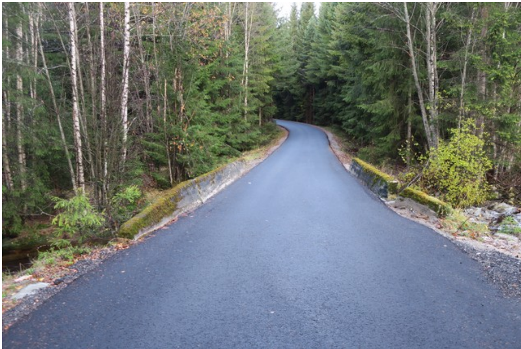
Bilde 2: Oversiktsbilde sett over brua
