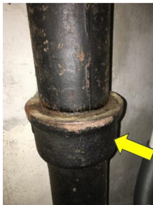
Figur 1 Gammelt avløpsrør av støpejern. Pilen viser plassering av eventuell asbestholdig tettemasse. Det er kun denne typen støpejernsrør vi kjenner til at det kan være brukt asbest i. Det er imidlertid ikke uvanlig at rørene er malt utenpå.
