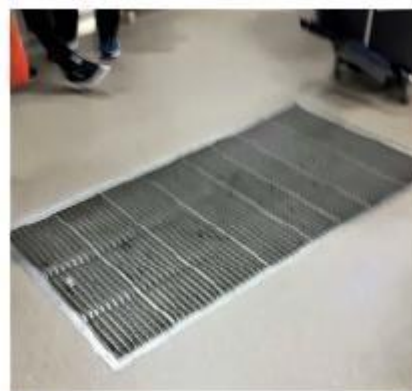
Referansebilde av gulvrist med sandfanger og sluk
