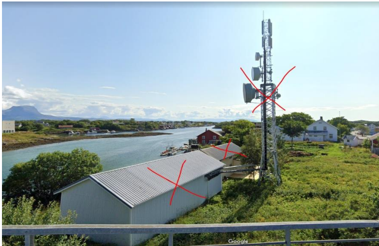
Telenorbygg merket med rødt kryss, betongfundament mast og mast, rives
