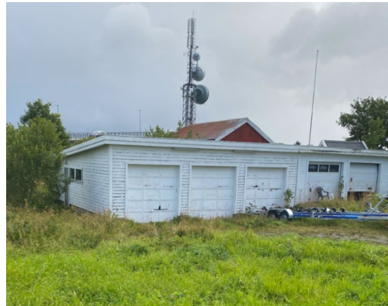
Bilde 9: Fasadebilde av garasje. Kun deler av garasjen er planlagt revet.
