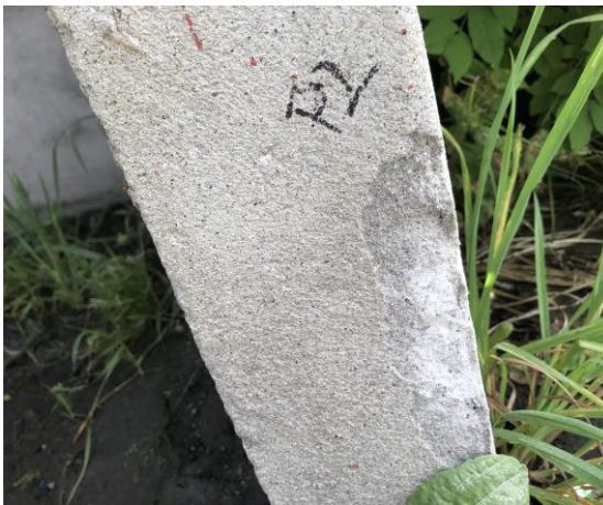
Figur 14 Grunnmur på kioskbygning, vestside.
