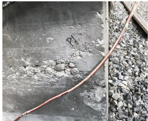
Figur 15 Grunnmur på kioskbygning, østside.
