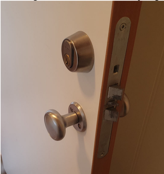
Figur 2 Typisk utførelse låskasse og virder på innerdører.
