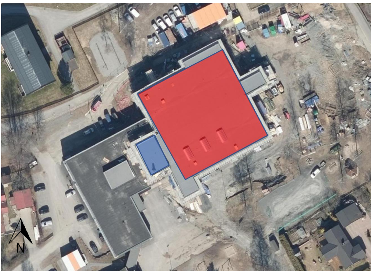
Figur 1: Hoberg skole med takflate for solcelleanlegg på bygg A markert med rødt.
