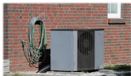
Figur 3-3 Eksempel på uteluft-varmepumpe for oppvarming og varmtvannsberedning.
