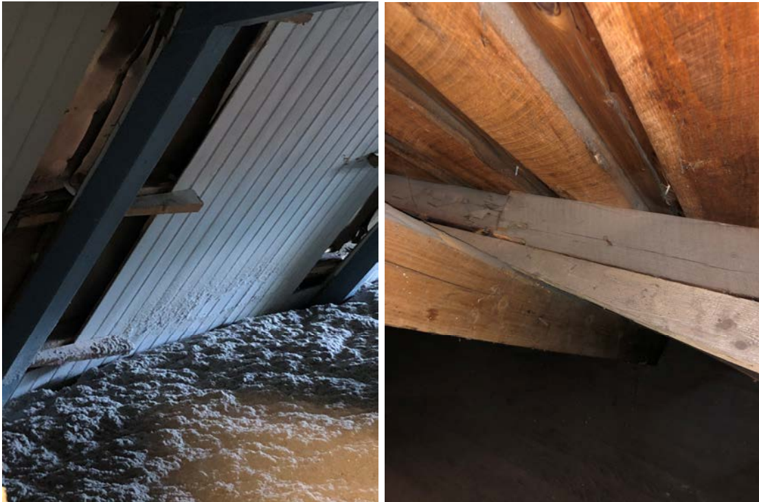
Bilde 3: Avretning av takflate
