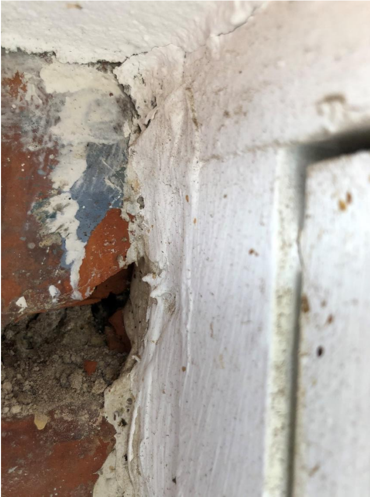
FIGUR 4. BLÅTT FARGESPOR PÅ TEGL UTENFOR VINDUSKARM VISER TIDLIGERE FARGESETTING TILSVARENDE FUNN PÅ GRANLY INTERNAT. DET ER IKKE FUNNET OPPRINNELIG MALING PÅ TREVERKET. (FOTO: MUR OG MER, JUNI 2020).
