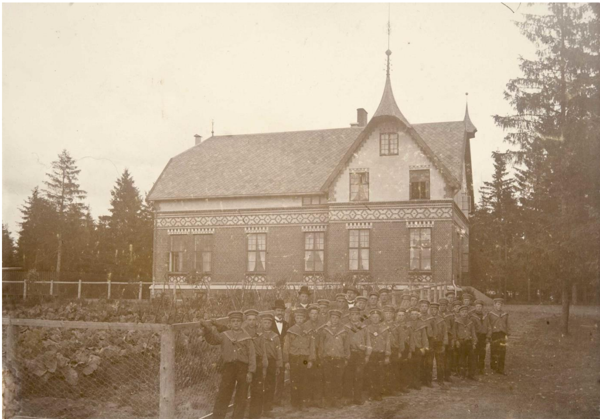
FIGUR 10. BREIDABLIKK SETT FRA SYDVEST CA. 1903. FOTOGRAF UKJENT. TREVERKET ER MALT I EN MØRKERE FARGE. DE PUSSETE VEGGENE ER LYSE ENSFARGET, MEN EN DEL SYNLIGE SKJOLDER. EIER: NORSK FOLKEMUSEUM INVENTAR NR. ???
