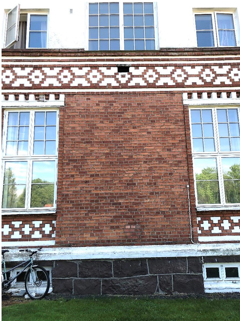
FIGUR 2. OPPRINNELIG TEGL OG NATURSTEINSMUR ER HOVEDSAKELIG FUGET OM. VINDUENE ER SKIFTET TIL KOPIVINDUER MED TILSVARENDE UTFORMING SOM DE OPPRINNELIGE. (FOTO: MUR OG MER JUNI 2020).
