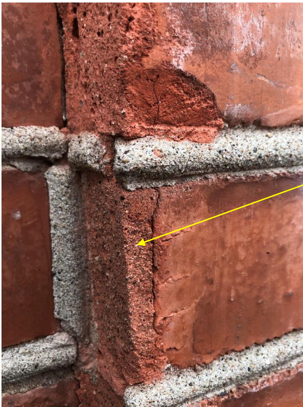
FIGUR 3. ØVERST T.V. HVITMALTE VINDSKIER OG HYLLEBORD ER SEKUNDÆRE OG HAR ERSTATTET OPPRINNELIG MØRKT MALT TREVERK. SEMENTRIKE SEKUNDÆRE PØLSEFUGER, SÆRLIG I GAVL OG I DEKORFELT UNDER VINDUENE. (SE FIG.10) . T.H. OMPUSSEDE PARTIER I FORBINDELSE MED UTBEDRET SKADE PÅ DRAGER. VINDU. GAVLPARTI, VEST. NEDERST T.V.: ELDTRE PØLSEFUGE SAMMEN MED NYERE SEMENTPØLSEFUGE (GUL PIL) VED UTBEDRING AV SKADE I TILKNYTNING TIL JERNDRAGER, VINDU. T.H. SKADET TEGL ER FLERE STEDER REPARERT MED INNFARGET MØRTEL. (FOTO: MUR OG MER, JUNI 2020).
