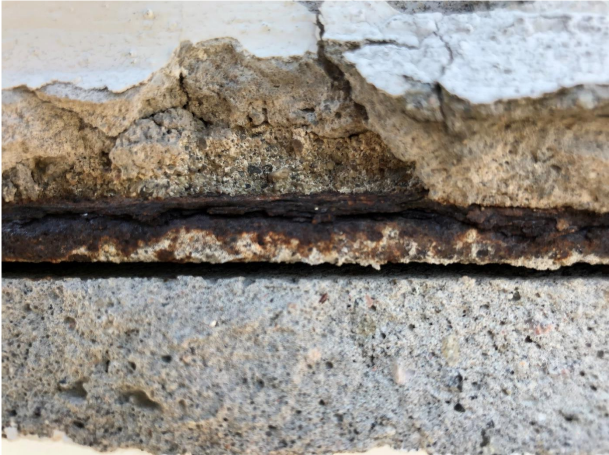
FIGUR 8. DETALJ JERDRAGERENS OVERFLATE SOM ER PORØS I YTTERSJIKTET, MEN MED UVISS TILSTAND LENGRE INN I GODSET, FIGUR 7. (FOTO: MUR OG MER, JUNI 2020).
