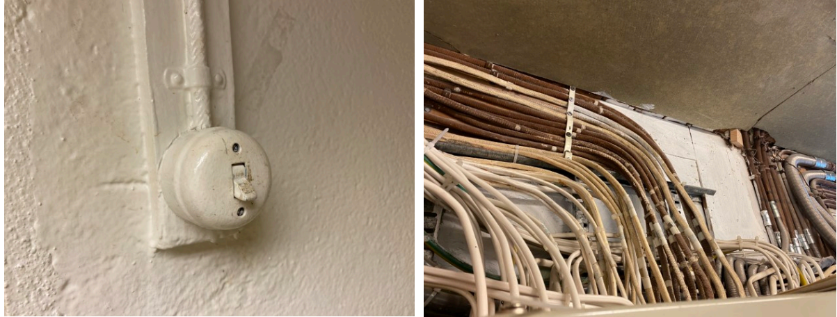
Figur 15 – Bakelittprodukter og trådisolerte ledninger inneholder asbest. Bakelittprodukter og trådisolerte ledninger som fjernes, sorteres i egen fraksjon og leveres godkjent mottak.
