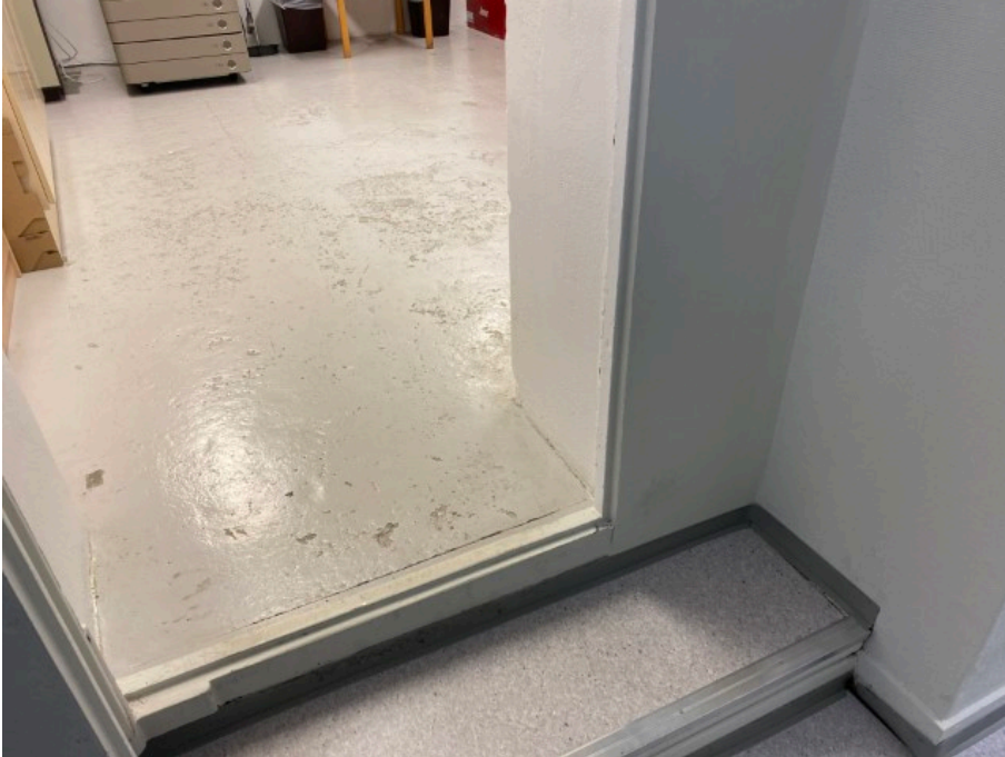
Figur 18 - Trinn til safe og vegg/himling/golv, som kan inneholde asbestholdige materialer som brannhemming.
