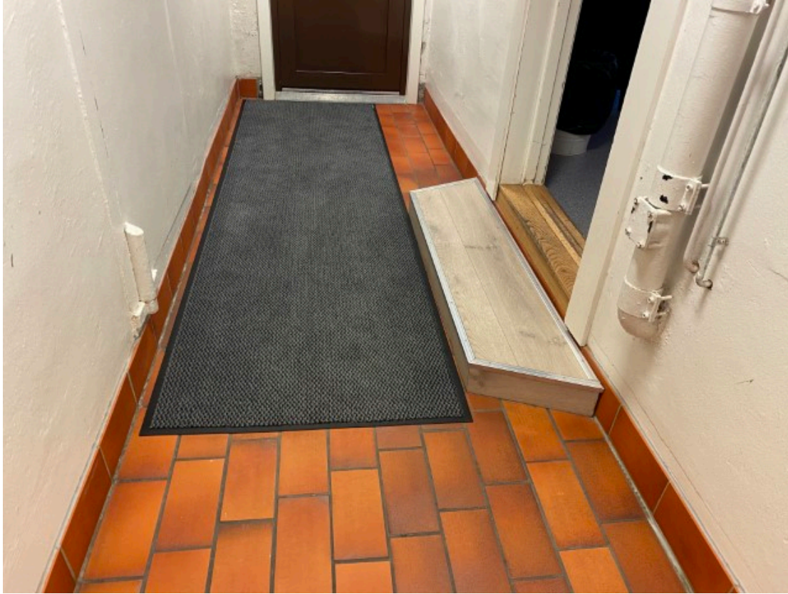
Figur 7 – Korridor i underetasjen
