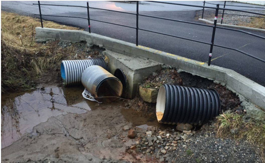
Figur 5 Innløp til rør gjennom Vasstrandvegen. Bildet er tatt 16.12.2016.
