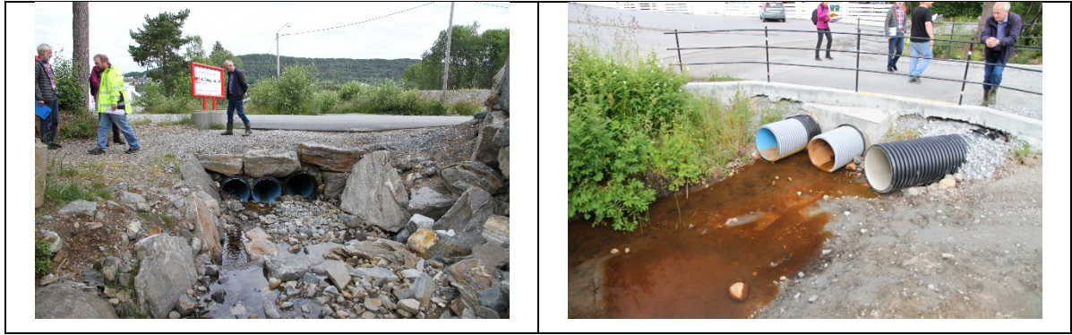
Figur 2-2 Bilder av kulverter under veier, øverst (venstre) og Vasstrandvegen. Begge bildene er tatt oppstrøms for veien.
