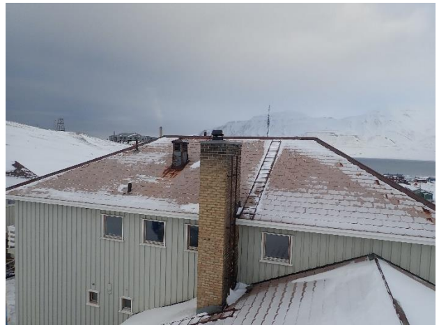
Bilde 5: Asbestholdige takplater på boligbygg
