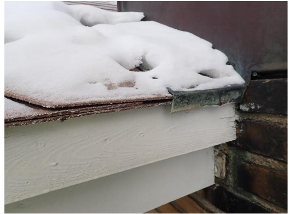
Bilde 42: Overgang mot taket til boligdelen, på siden
