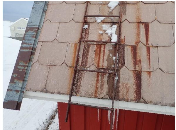
Bilde 44: Rustet stige på tak nedenfor klocketårnet
