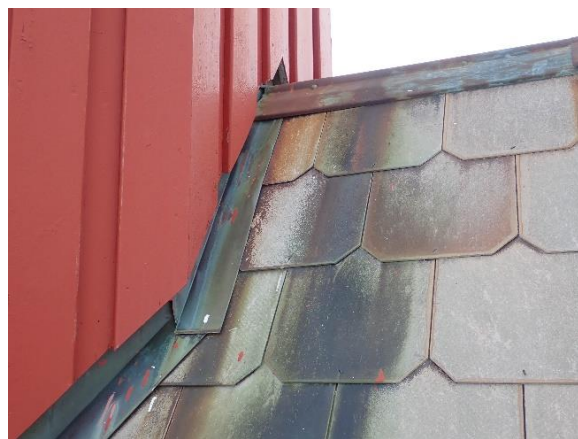
Bilde 14: Beslag rundt klokketårn med avfarging på taksteinene rundt
