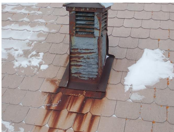
Bilde 27: Takhatt knyttet til kasse på loftet tilhørende boligdelen
