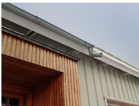
Bilde 22: Takrenne over inngangen, med utkast på ene siden
