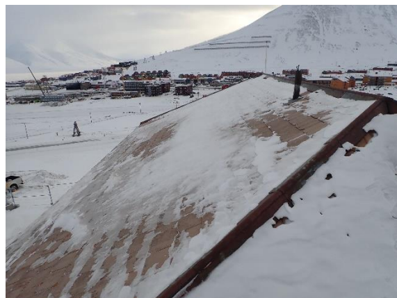
Bilde 6: Takflate på boligdelen, mot nord
