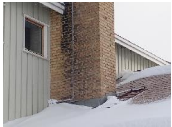
Bilde 38: Pipe med overgang mot yttervegg
