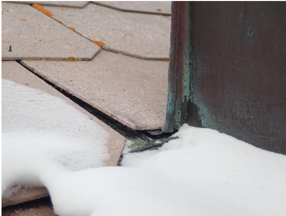
Bilde 41: Overgang mot taket til boligdelen, på baksiden
