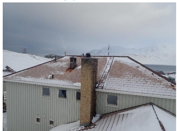
Bilde 46: Stiger på mellom- og boligbygget, også opp langs skorstein.
