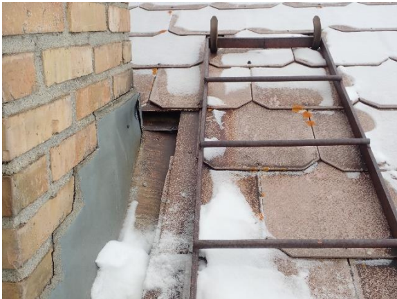
Bilde 39: Overgang mot yttertaket til mellombygget
