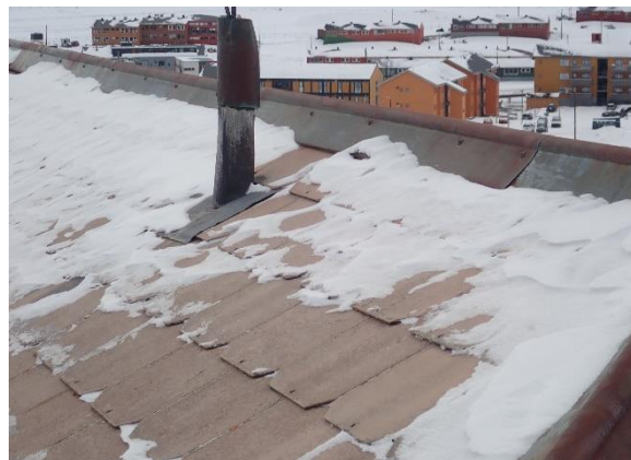
Bilde 30: Takhatt på nordsiden av boligbygget
