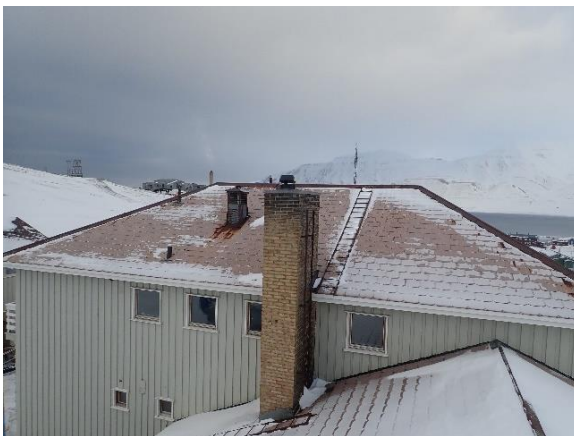
Bilde 37: Pipe sett fra nordsiden
