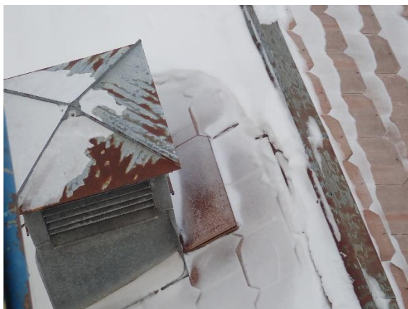
Bilde 25: Takhatt plassert på mellombygget
