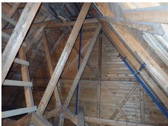
Bilde 49: Innvendig konstruksjon under klokketårn, regnes som kaldt «loft»
