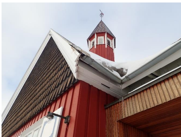
Bilde 17: Vinkelrennebeslag med is i, over inngangen til kirken.
