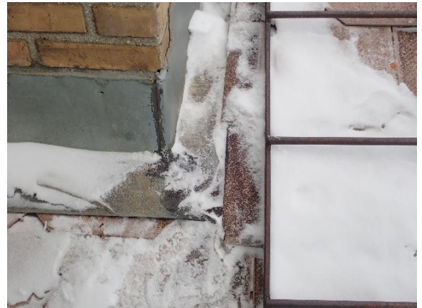
Bilde 40: Beslag går under takplater, sett ovenfra
