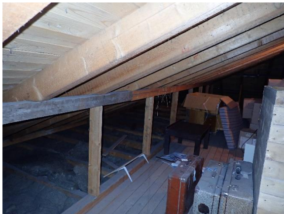
Bilde 31: Innvendig takkonstruksjon over boligdelen
