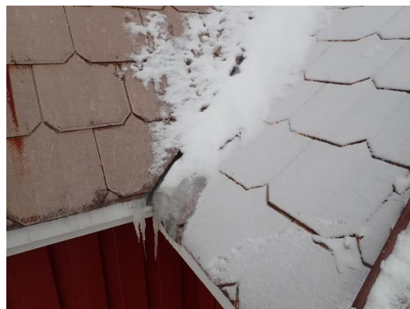
Bilde 18: Vinkelrennebeslag med is i, på vestsiden av kirken
