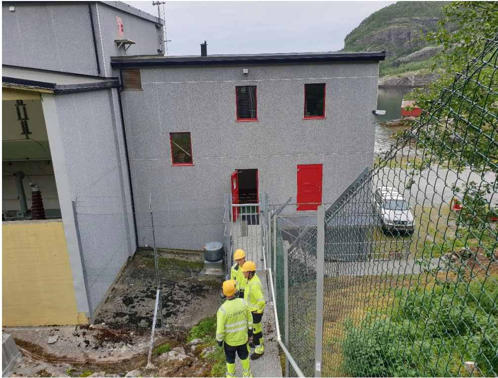
Bilde 5 - Kraftstasjon - fasade. Rom F6 ved vindu øverst til høyre. Fundament til diesel aggregat planlegges etablert på høyre side av nettingjerde.
