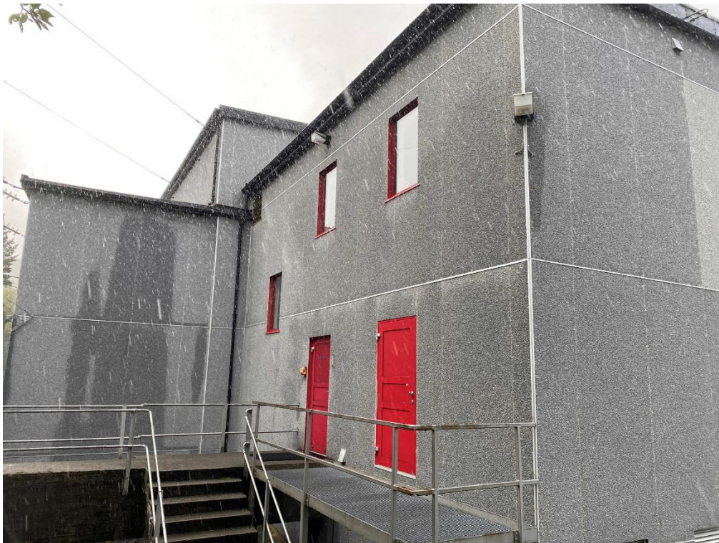
Bilde 4 - Kraftstasjon - fasade. Rom F6 ved vindu øverst til høyre
