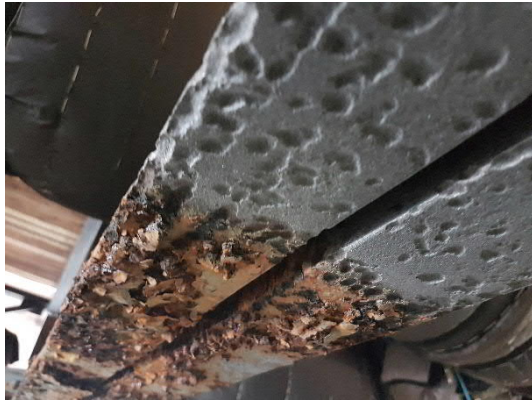
Figur 7 Undergurt på bærende takkonstruksjon.
