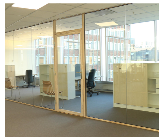
Kontorfront med tilsvarende utførelse med glassfelt, glassdør m ramme, hvitlaseret eik.
