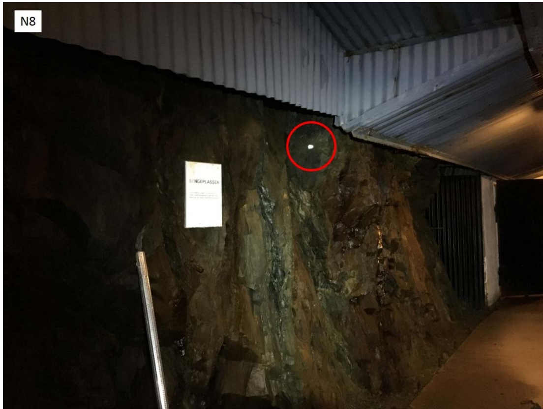
Figur 6: Markert plassering av anbefalt bolt ved lokalitet N8.
