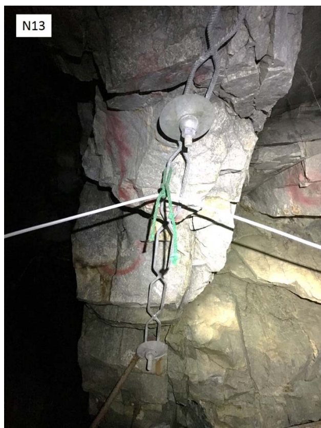
Figur 13: Eksempel på utført sikring i heng ved lokalitet N13.
