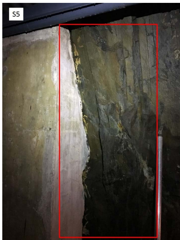
Figur 4: Delvis sprekkeavløst berg og behov for rensk ved lokalitet S5.
