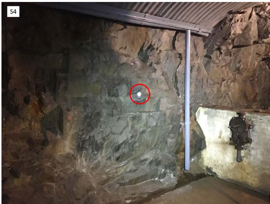
Figur 3: Markert plassering av anbefalt bolt ved lokalitet S4. Anbefalt boltelengde 2 meter.
