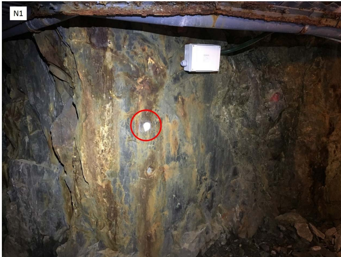
Figur 2: Markert plassering av anbefalt bolt ved lokalitet N1.
