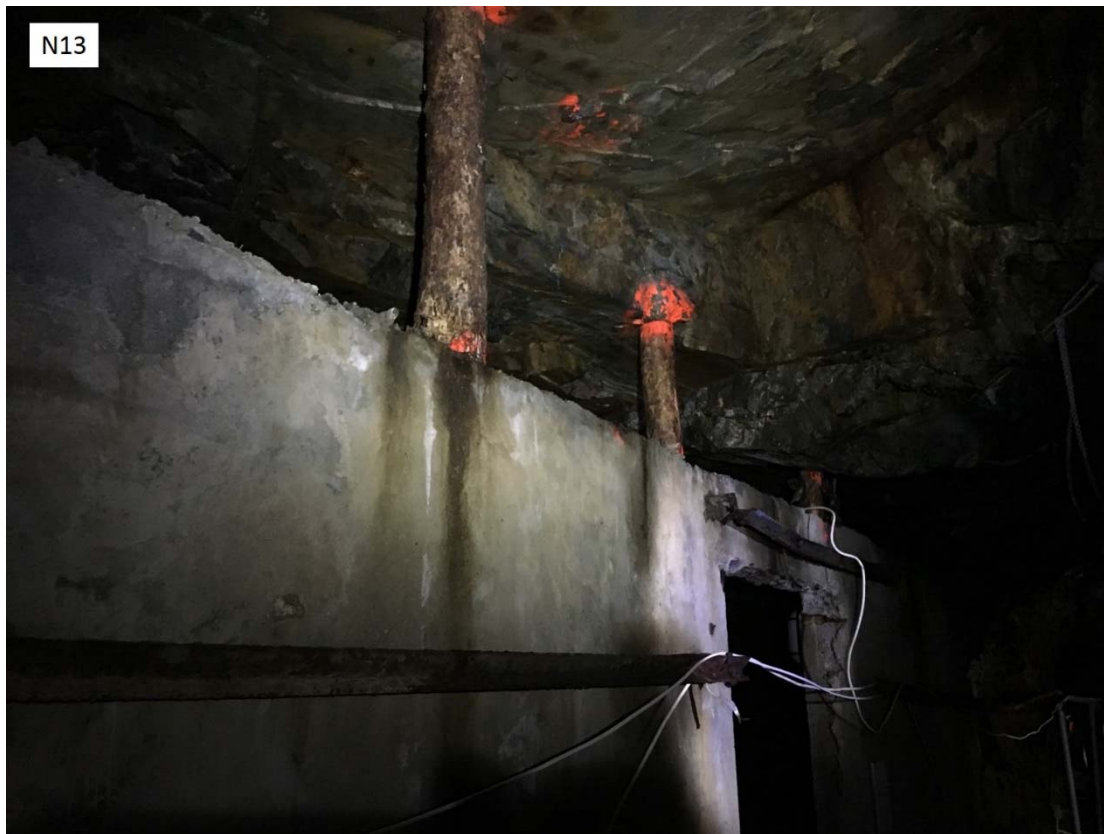
Figur 10: Eksempel på utført sikring i heng ved lokalitet N13.
