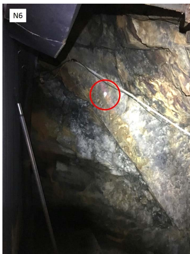
Figur 5: Markert plassering av anbefalt bolt ved lokalitet N6.
