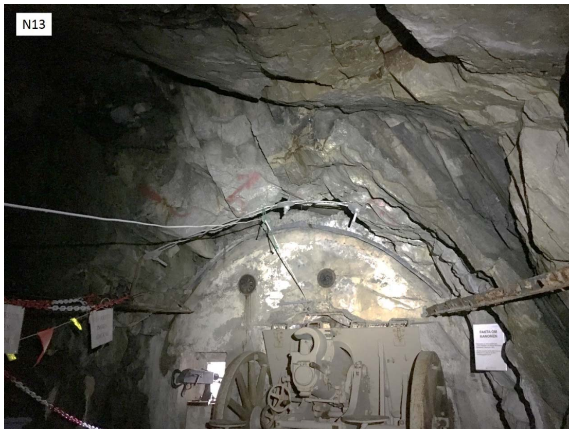
Figur 12: Eksempel på utført sikring i heng ved lokalitet N13.
