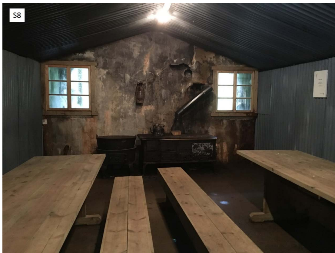
Figur 7: Plater i heng og vegg ved lokalitet S8. Vær oppmerksom ved senere inspeksjoner.
