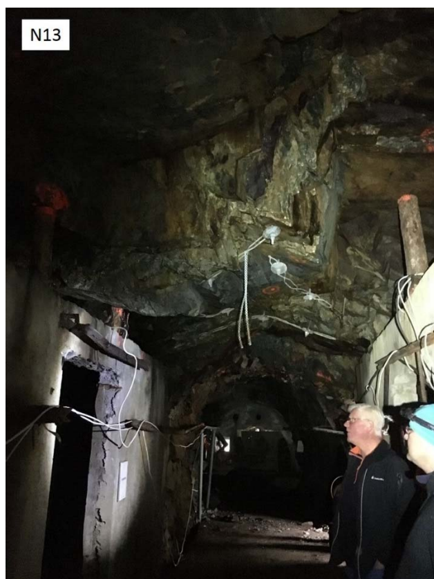
Figur 9: Eksempel på utført sikring i heng ved lokalitet N13.
